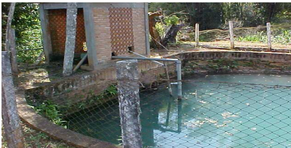
FIGURA 3: Mina Beco do Portelo – Doresópolis
