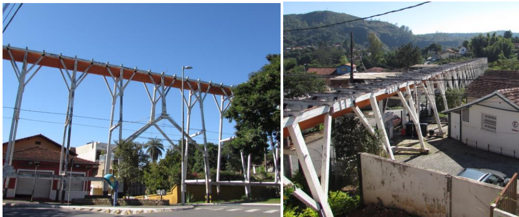
Figura 14 – Fotos do Aqueduto do Bicamente
