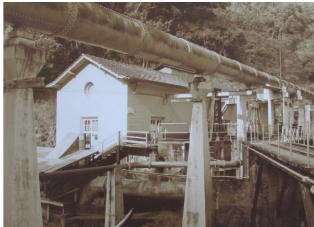
Figura 12 – Foto da Usina em Rio de Peixe
