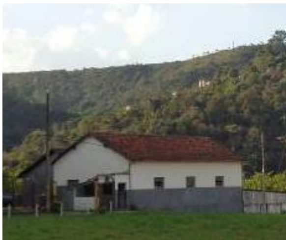
Vestiário e Sondagem
