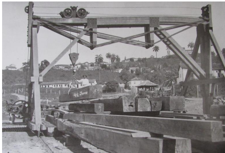
Figura 7 – Foto armazém de madeira
