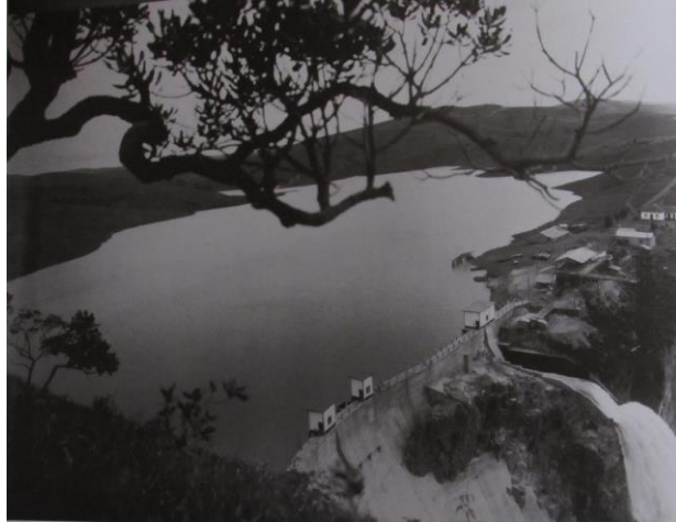
Figura 11 – Foto da barragem da Lagoa das Codornas
