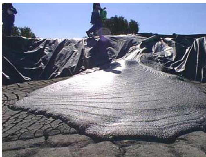
Figura 3.2: Disposição superficial de pasta mineral (Theriault et. al. , 2001).
