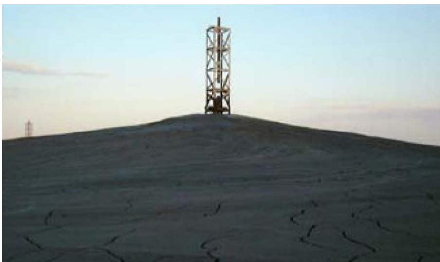
Figura 3.14: Sistema de disposição com torre central (Therriault et. al. , 2001).
