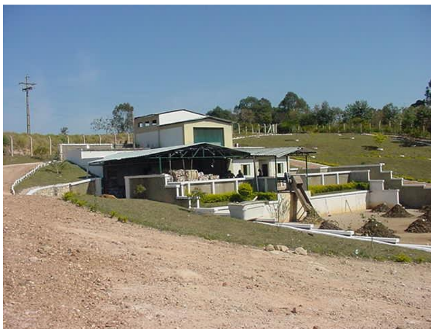
Figura 1.1 – Vista parcial da usina de triagem e compostagem de lixo de CXC
