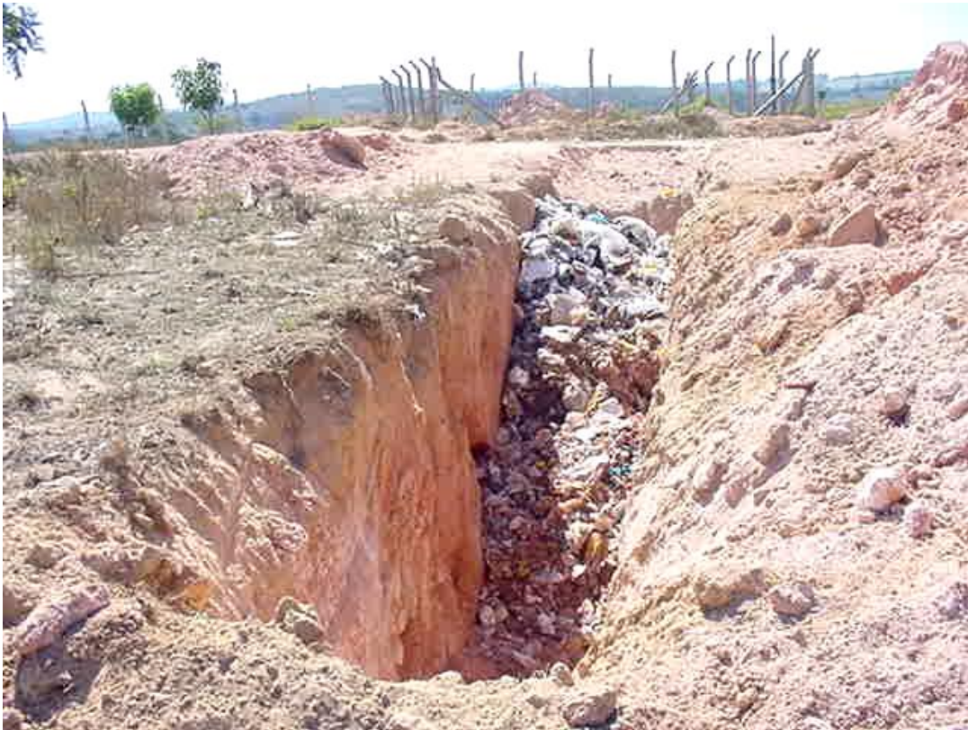
Figura 5.9 – Vala de rejeitos da UTC de CXC, em primeiro plano e de RSS, ao fundo
