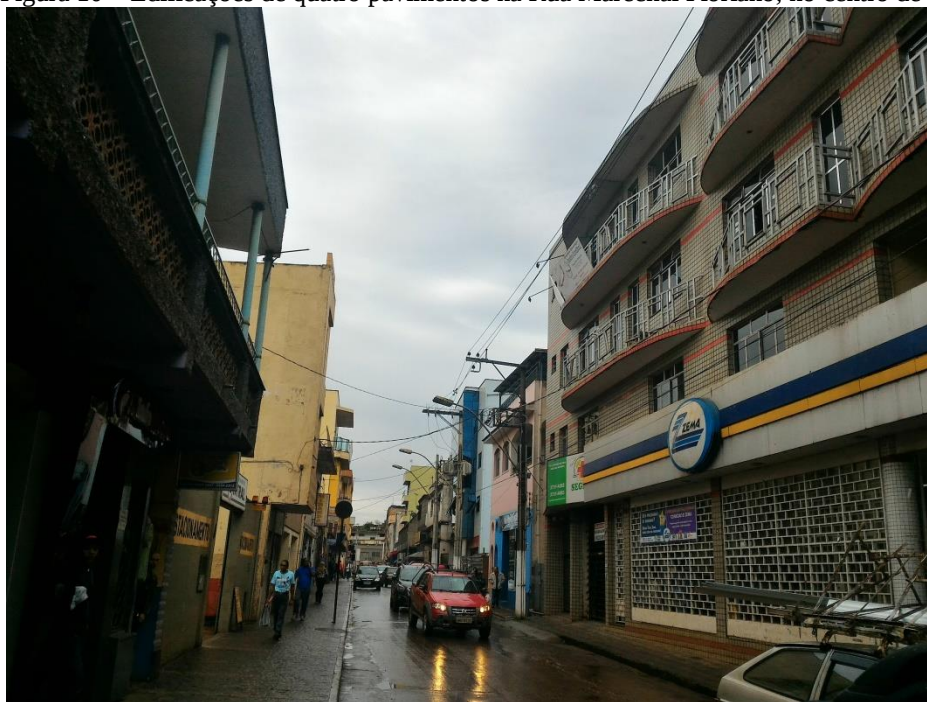
Figura 10 – Edificações de quatro pavimentos na Rua Marechal Floriano, no centro de Congonhas
