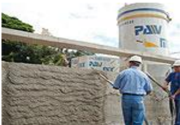
Fig. 15 – Aplicação de argamassa com utilização de bomba de projeção
