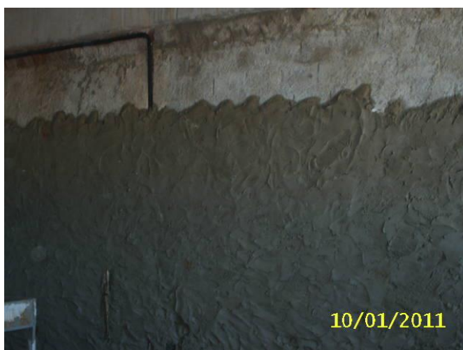
Figura 4 – Reboco ou massa única aplicado manualmente (Topus Construtora 2010)
