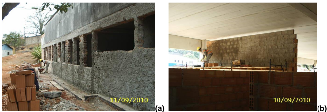
Figura 2 (a) e (b) Chapisco aplicado manualmente (Topus Construtora 2010)
