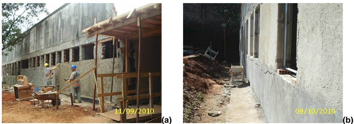
Figura 3 (a) e (b) – Emboço aplicado manualmente (Topus Construtora 2010)
