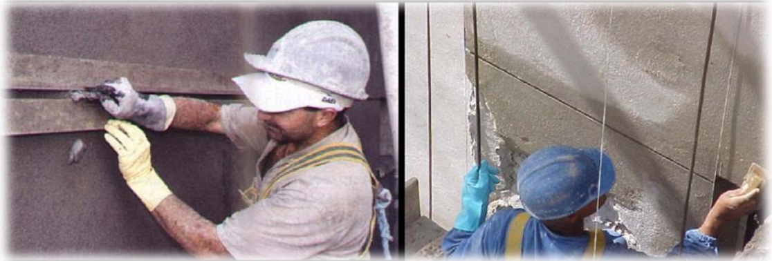
Fig. 8 – Execução das juntas de movimentação
