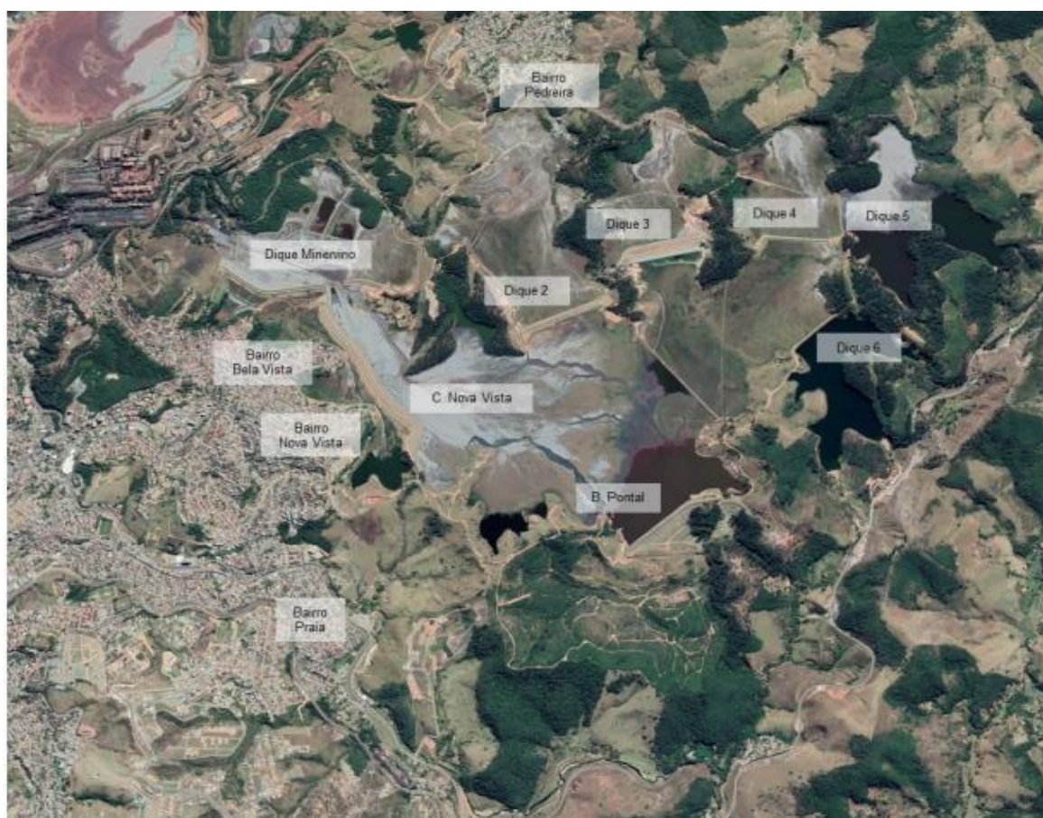
Figura 33 – Bairros vizinhos e estruturas de barramento do Sistema Pontal
