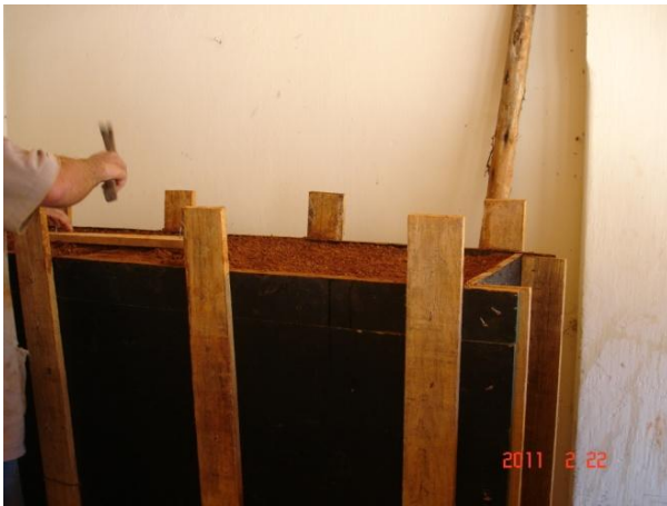
FIGURAS 44 e 45 – Compactação do painel 2
