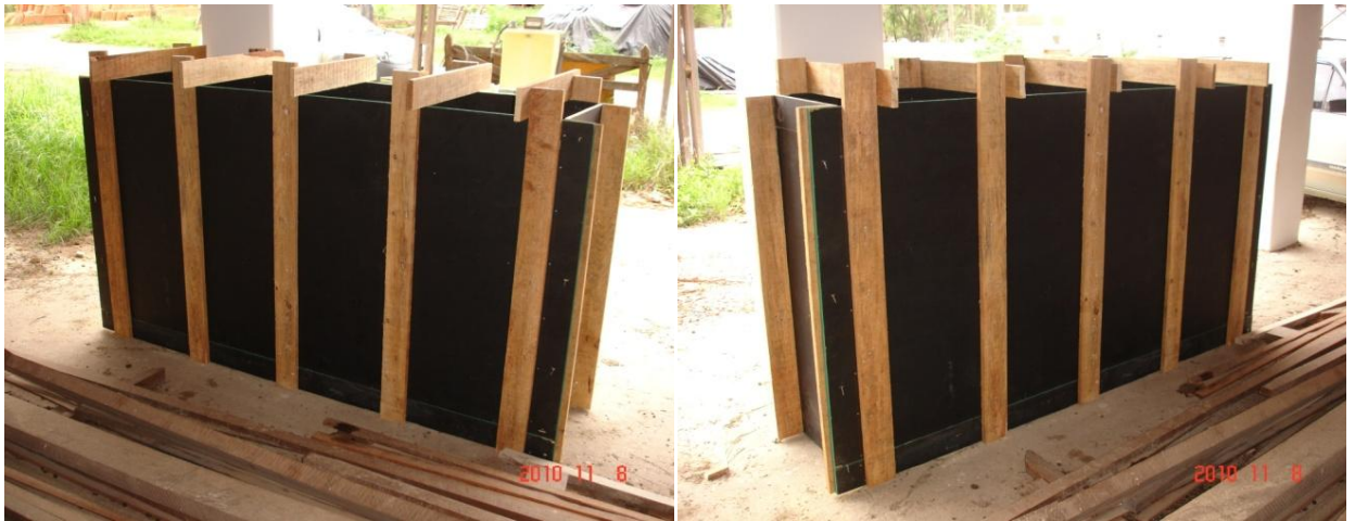
FIGURAS 22 e 23 – Execução das fôrmas dos painéis
