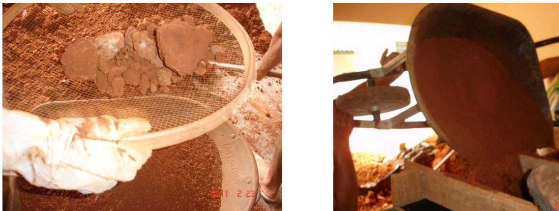
FIGURAS 51 e 52 – Peneiramento e colocação da terra para painel 4
