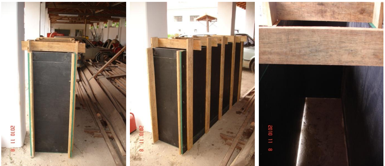
FIGURAS 24, 25 e 26 – Execução das fôrmas dos painéis
