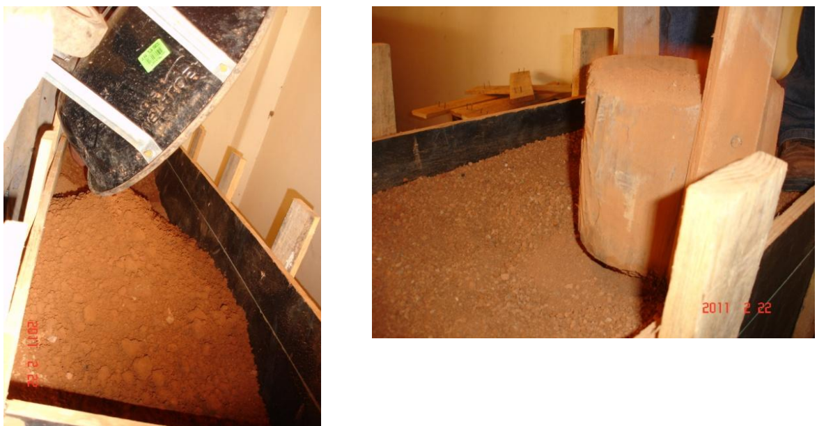
FIGURAS 40 e 41 – Compactação do painel 2
