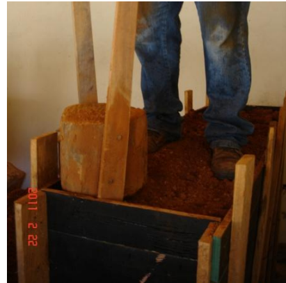
FIGURAS 42 e 43 – Compactação do painel 2
