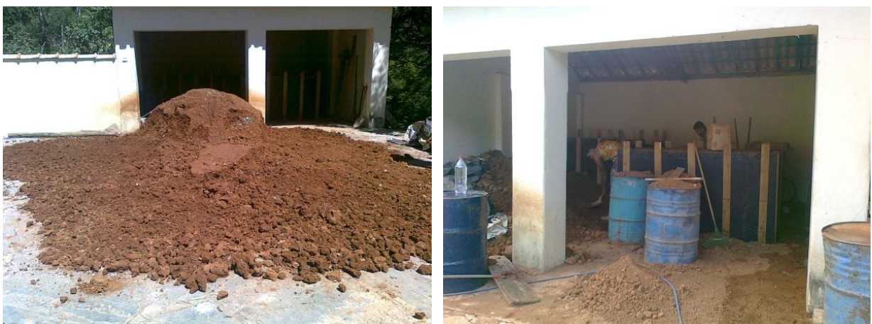
FIGURAS 36 e 37 – Secagem e nova estocagem da terra para execução dos demais painéis
