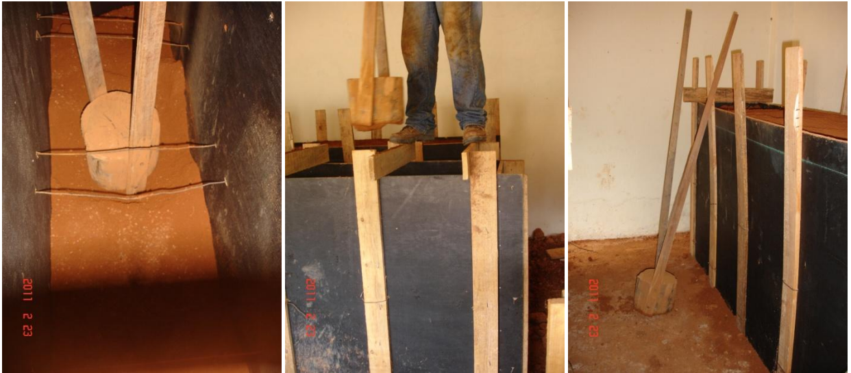
FIGURAS 48, 49 e 50 – Compactação do painel 3
