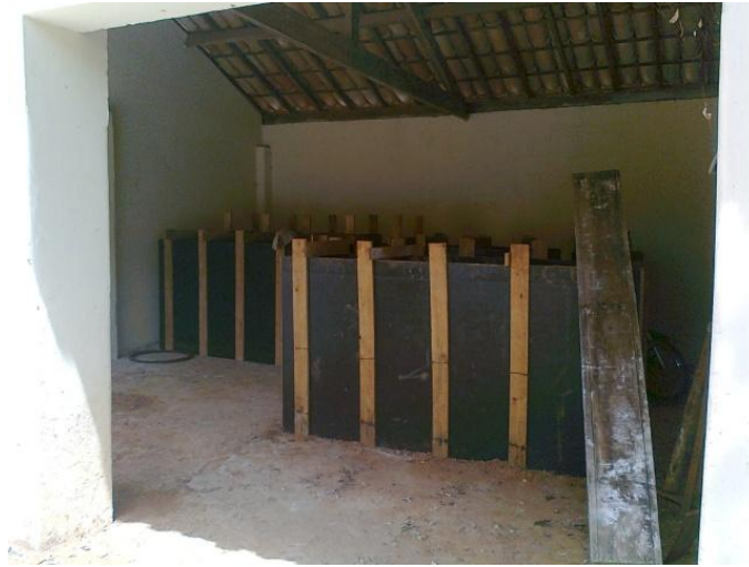
FIGURA 27 – Local de construção dos painéis
