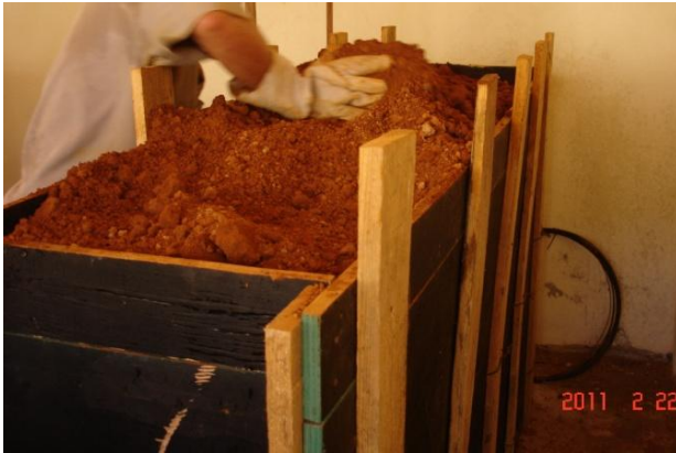
FIGURAS 42 e 43 – Compactação do painel 2
