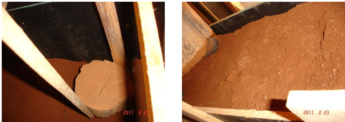
FIGURAS 53 e 54 – Compactação do painel 4
