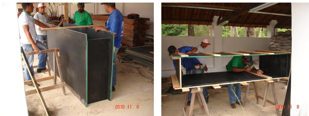
FIGURAS 20 e 21 – Execução das fôrmas dos painéis
