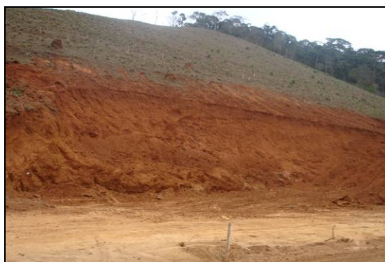
Figura 12 - Caixa de empréstimo em exploração Fonte: CARDOSO, 2007
