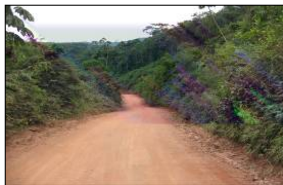
Figura 44 – Vista panorâmica do trecho Fonte: ENECON, 2007
