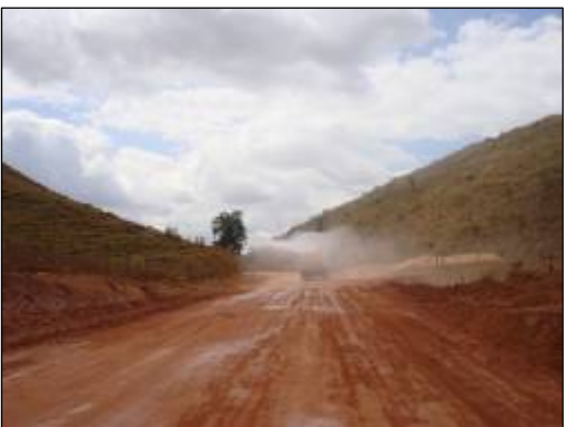
Figura 61 – Aspersão de água na pista Fonte: CARDOSO, 2007
