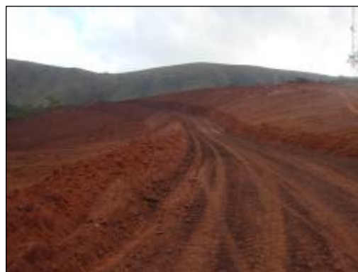
Figura 64 – Caminho de serviço Fonte: ENECON, 2007
