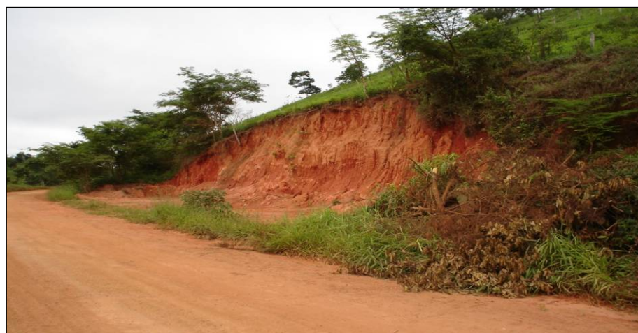
Figura 35 – Retirada de material por terceiros Fonte: ENECON, 2007
