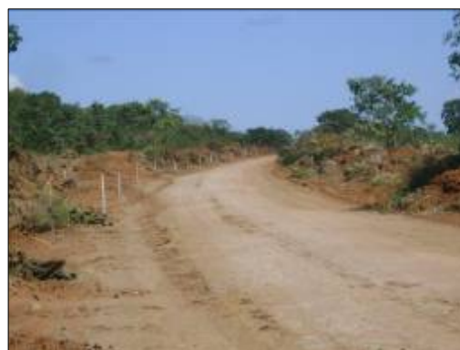
Figura 66 – Limpeza do terreno Fonte: CARDOSO, 2009
