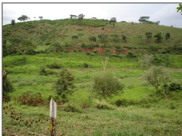
Figura 45 – Presença de solo mole no trecho Frei Lagonegro – Entr.º MG-117 Fonte: ENECON, 2007
