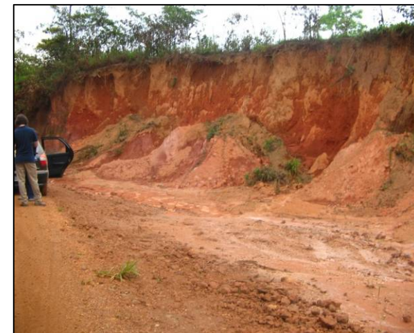
Figura 30 - Retirada de material por terceiros Fonte: ENECON, 2007
