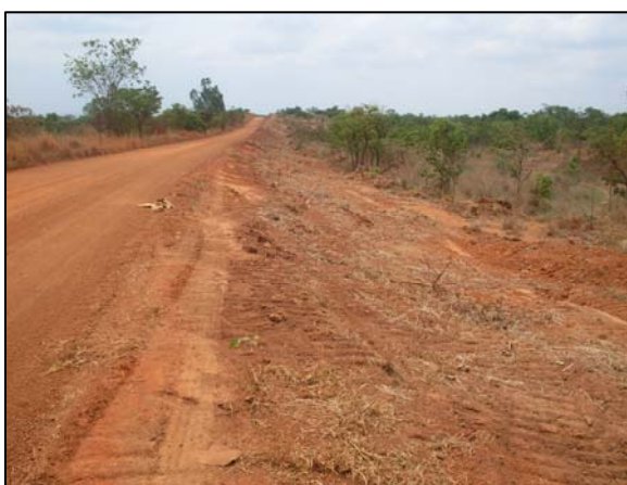
Figura 7 – Limpeza do Terreno Fonte: CARDOSO, 2009
