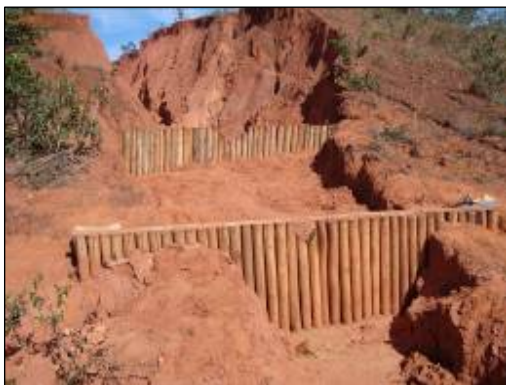
Figura 62 – Paliçada para contenção de voçoroca Fonte: CARDOSO, 2009
