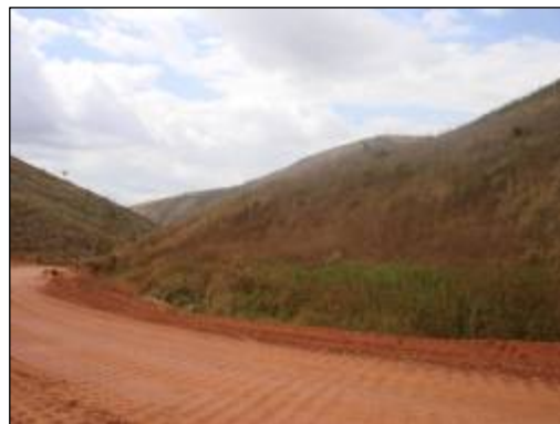
Figura 58 – Plataforma em fase de compactação Fonte: CARDOSO, 2007
