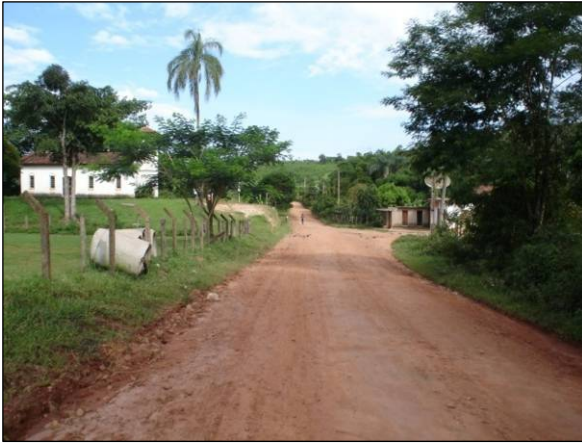
Figura 25 – Travessia de povoado Fonte: ENECON, 2007
