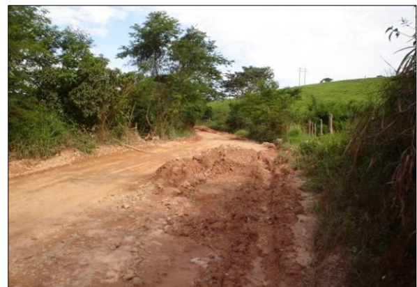
Figura 24 – Vista geral do trecho Dom Joaquim – Entr. MG-010 Fonte: ENECON, 2007
