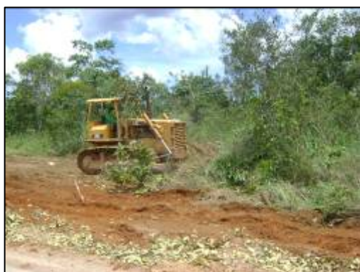
Figura 65 – Remoção de camada vegetal Fonte: CARDOSO, 2009
