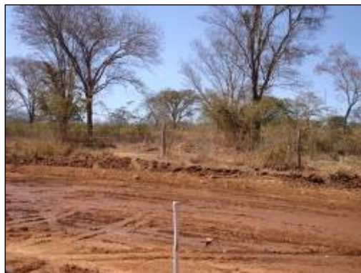
Figura 52 – Acabamento de terraplenagem Fonte: CARDOSO, 2007
