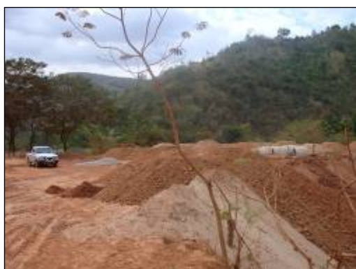
Figura 55 – Material de empréstimo estocado Fonte: CARDOSO, 2007
