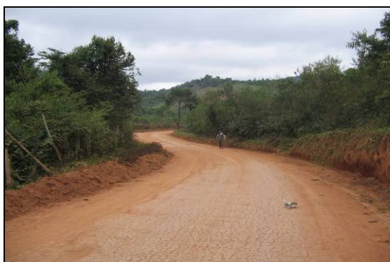
Figura 43 – Vista panorâmica do Trecho Fonte: ENECON, 2007
