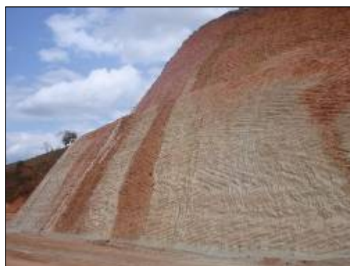
Figura 54 – Talude de corte em execução Fonte: CARDOSO, 2007
