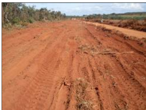
Figura 67 – Limpeza do terreno Fonte: CARDOSO, 2009
