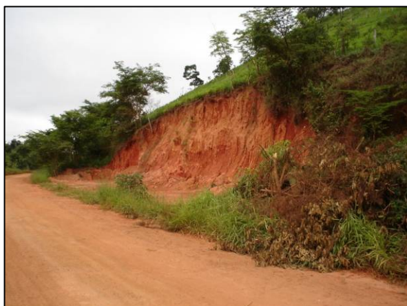
Figura 40 – Retirada de material por terceiros Fonte: ENECON, 2007
