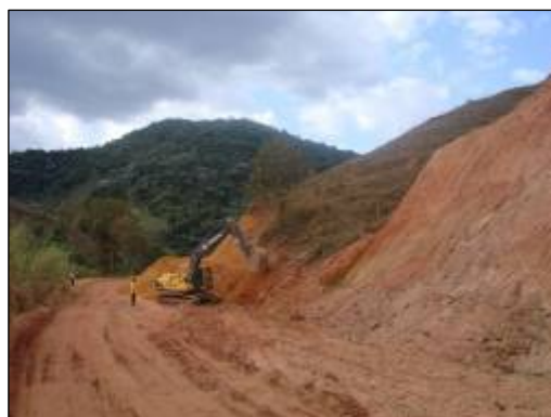
Figura 59 – Escavação em corte Fonte: CARDOSO, 2007
