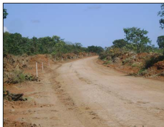
Figura 8 - Remoção de camada vegetal Fonte: CARDOSO, 2009
