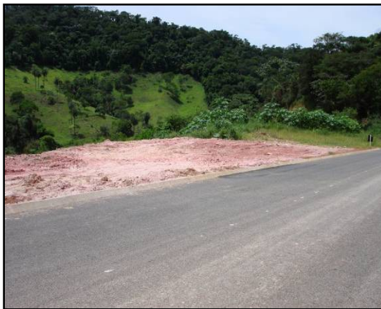
Figura 14 – Bota-fora sem revegetação Fonte: CARDOSO, 2008
