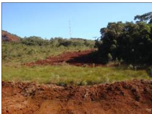
Figura 63 – Remoção de camada vegetal Fonte: CARDOSO, 2009
