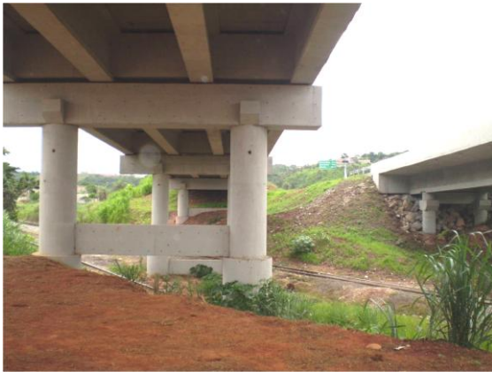
FIGURA 38 – Bairro Canaan – Linha férrea sob a BR-262
