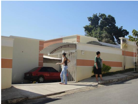
FIGURA 12 – Residencial Cipreste, localizado na rua Thomas Edson/55, bairro Canaan
