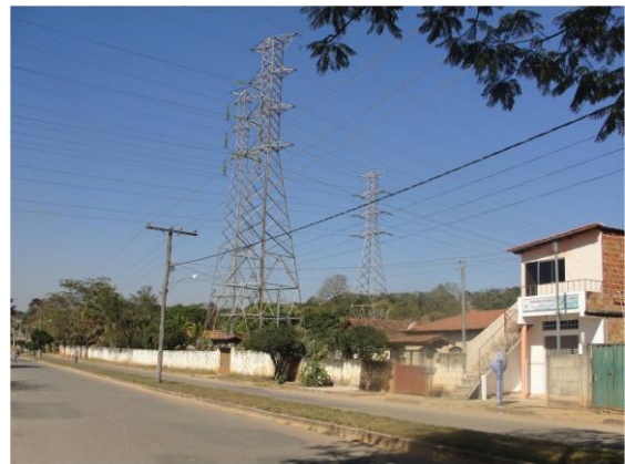
FIGURA 29 – Bairro Santo Antônio – Avenida principal do bairro Santo Antônio, na região de “Francelinos”
