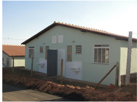
FIGURA 22 – Casa geminada construída pela CONSTRUTORA B
