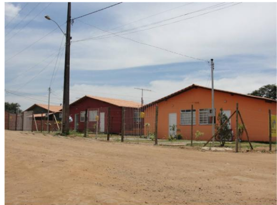
FIGURA 31 – Bairro Cidade Satélite – Via sem pavimentação onde está sendo executado empreendimento da CONSTRUTORA B Fonte: Arquivo da autora, fev/2011.
