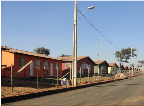
FIGURA 21 – Conjunto de casas geminadas construídas pela CONSTRUTORA B
