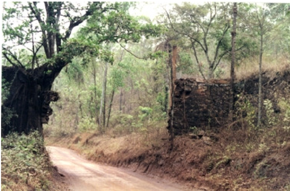
Figura 62: Ruína do portão oriental da mina em 1994.
