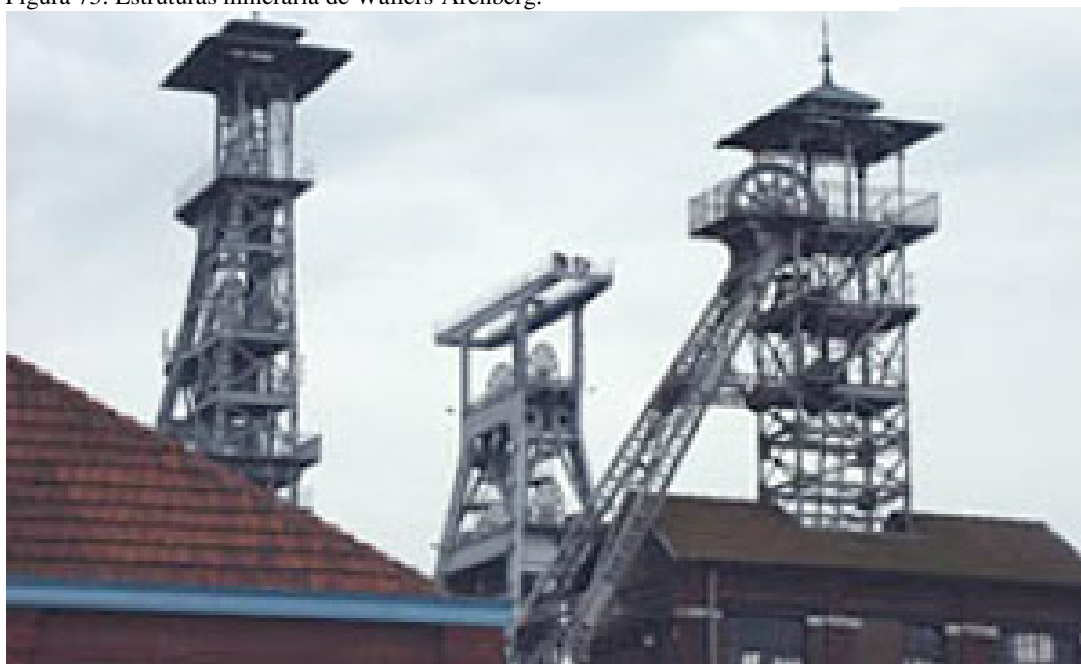
Figura 73: Estruturas minerária de Wallers-Arenberg.
