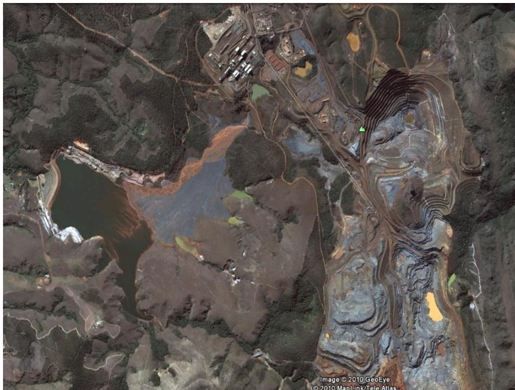
Figura 31: Vista aérea da mina do Pico de Itabirito.
