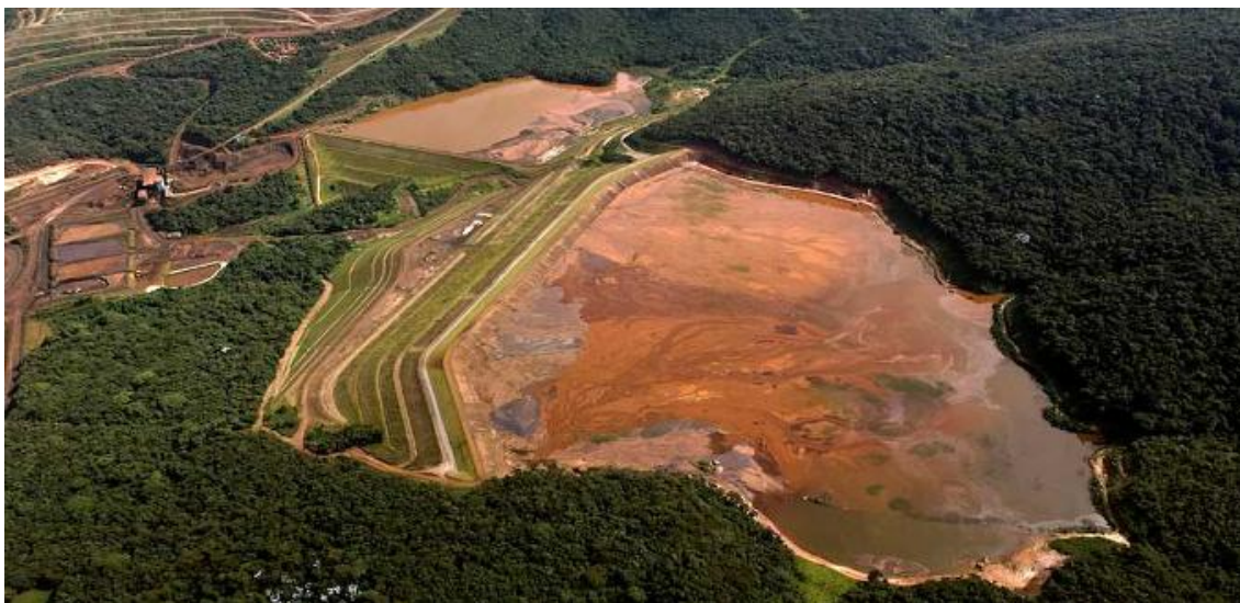
Figura 3.2 – Barragem I Mina Córrego do Feijão, Brumadinho/MG (Vale, 2009)
