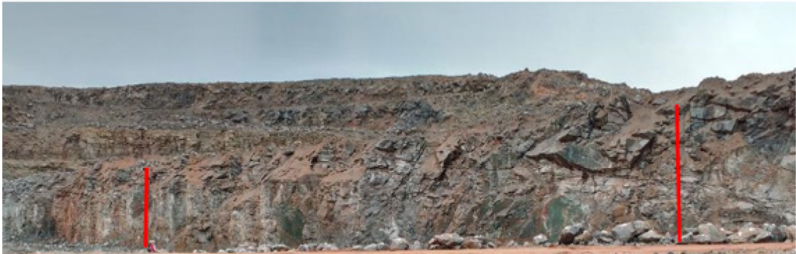
Figura 22 - Limpeza de frente e condição de face livre
