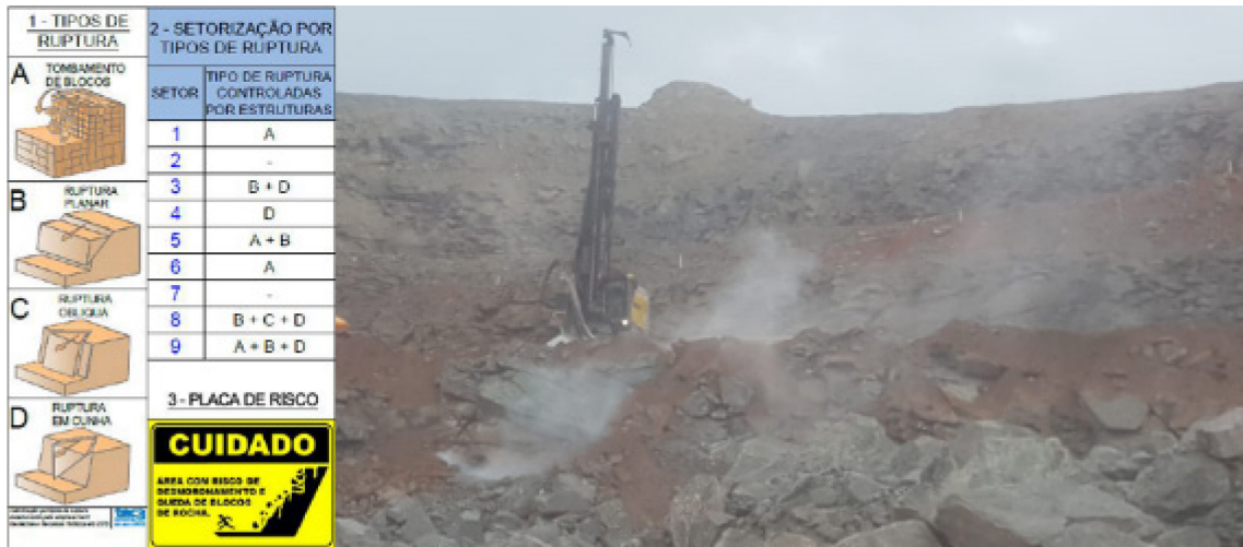
Figura 6 – Ar comprimido dissipado pelas fraturas durante a execução da perfuração
