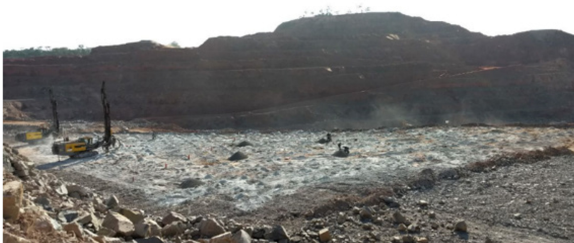
Figura 17 - Execução do Projeto de perfuração F01_150_007 em campo
