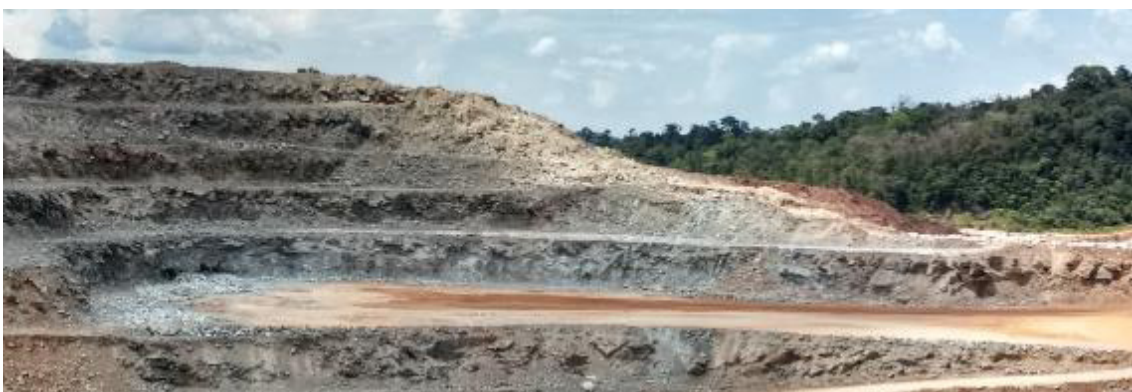
Figura 30 - Polígono F01_150_010 antes do desmonte
