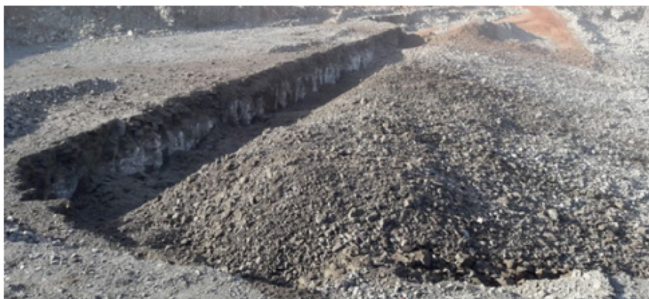
Figura 18 - Desmonte utilizando a técnica Smooth Blasting
