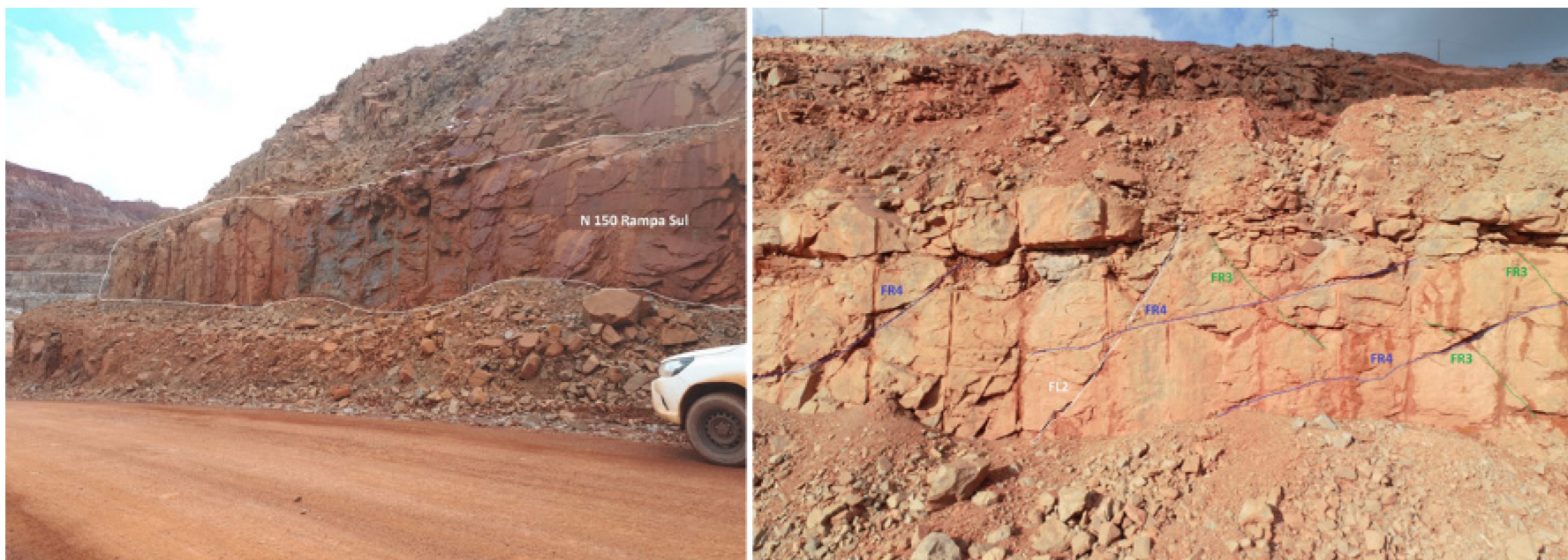
Figura 8: Mapeamento de estruturas da rocha da Mina de Pitinga
