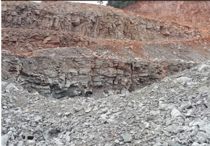
Figura 7: Tipos de discontinuidades, suas combinações no maciço e foto ilustrando o fraturamento aberto da rocha
