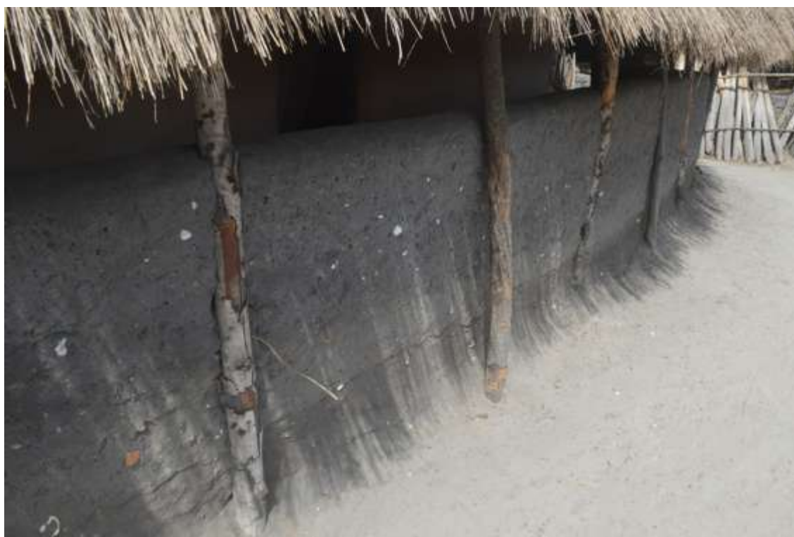
Fig. 218 - Paredes de casa com conchas em Elalab. Fotografia: autor
