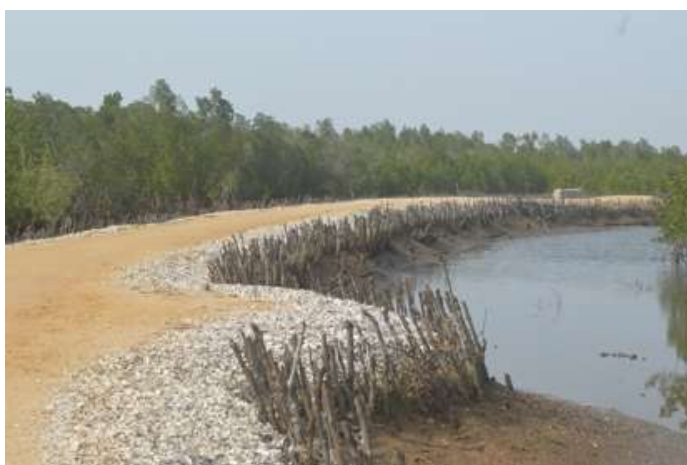
Fig. 201 - Caminho de Elia. Também possui as estruturas de madeira para evitar erosão.
