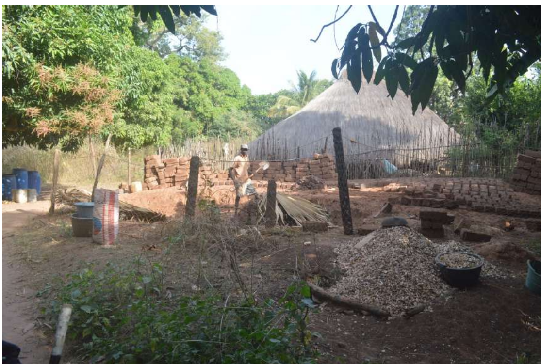
Fig. 219 - Construção de uma casa usando conchas – Yal/Varela. Fotografia: autor
