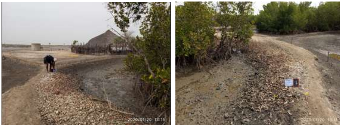
Fig. 195 - Djobel 9. Caminho se inicia próximo a um conjunto de casas
