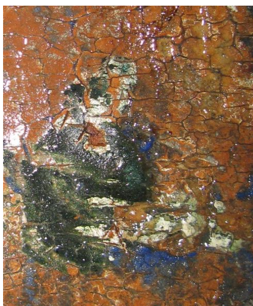
Figura 23: Detalhe do local da retirada
