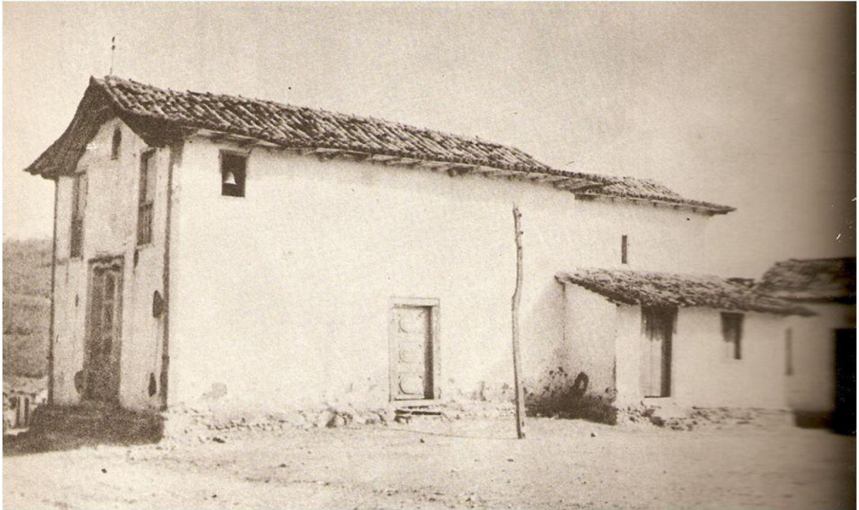
Figura 18 – Capela de São Gonçalo, Minas Novas, século XVIII.
