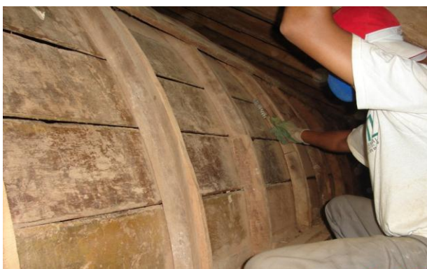
Figura 68 – Estrutura do forro da capela de Nossa Senhora do Rosário dos Homens Pretos, séc. XVIII, Chapada do Norte.
