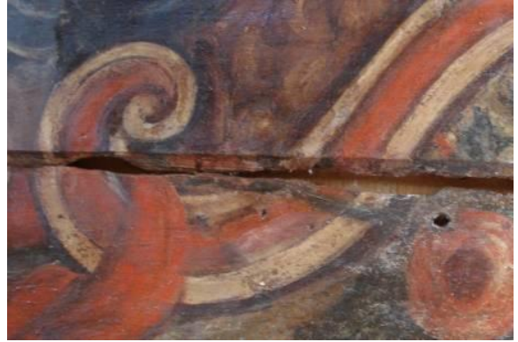
Figura 72 – Forro da capela-mor, capela de São Gonçalo, Minas Novas, séc. XVIII. O encaixe utilizado na capela de Nossa Senhora do Rosário dos Homens Pretos é o mesmo da capela de São Gonçalo, sem quaisquer calafetações. Foto: Carla Mabel, 2010.
