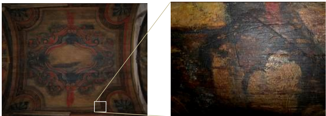
Figura 76 – Forro da capela-mor, capela de São Gonçalo, Minas Novas, século XVIII. No detalhe é possível ver os sulcos feitos na madeira para o traçado do desenho.
