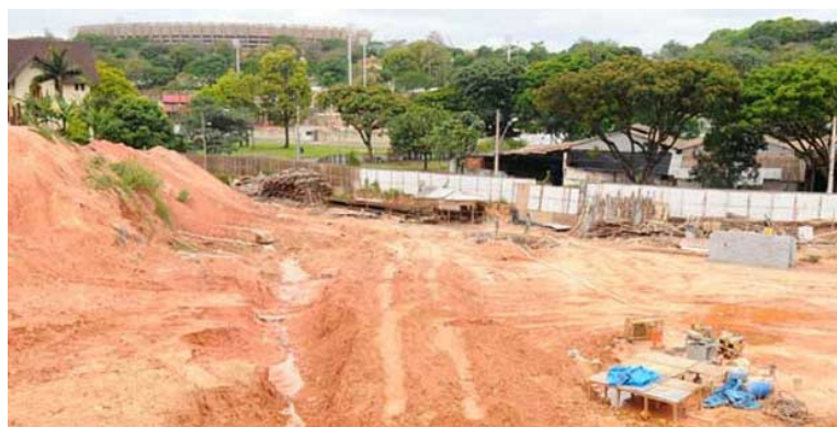
FIGURA 9 - Canteiro de obras na Avenida Alfredo Camarate Fonte: ESTADO DE MINAS, 1º de março de 2012.
