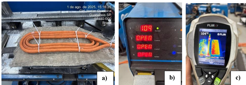
Figura 1 - a) Bobina de pré-aquecimento por indução b) Painel da máquina de pré-aquecimento por indução c) Câmera termográfica, mostrando a temperatura de pré-aquecimento.
