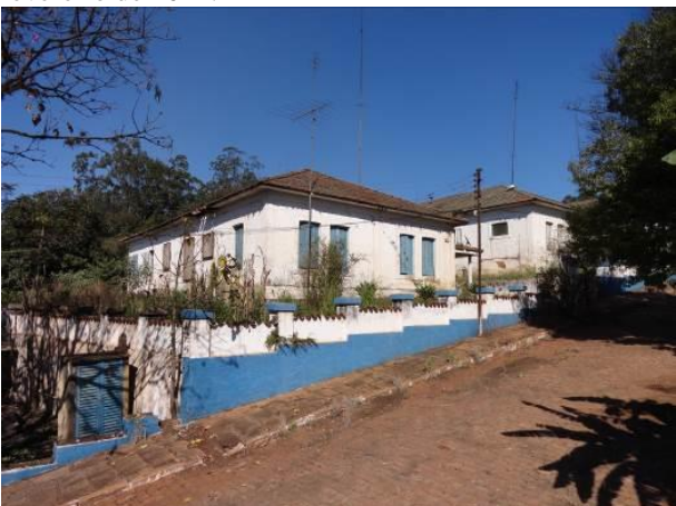
Figura 64: Detalhe da tipologia edilícia mais recorrente nas colônias, na Usina Tamoio, em Araquara, São Paulo. Foto: Mariana Gonçalves Moreira, julho de 2013.
