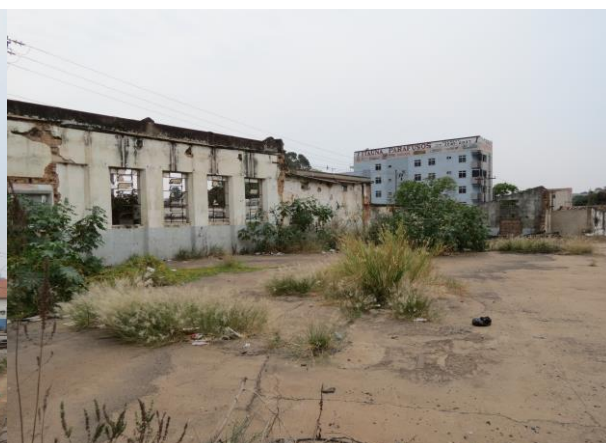
Figura 72: Área interna do edifício de atividades de suporte à tecelagem. Foto: Mariana Gonçalves Moreira. Outubro de 2012.
