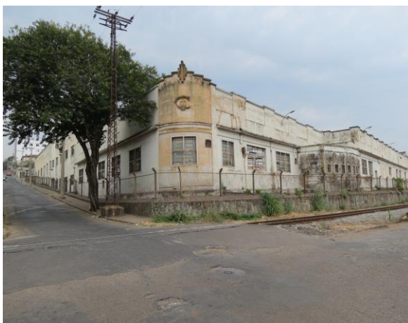
Figura 51: Fachada do setor de tecelagem da Unidade I da Companhia Industrial Itaunense. Nota-se a pintura desgastada e os vidros das janelas quebrados. Foto: Mariana Gonçalves Moreira. Janeiro de 2013.
