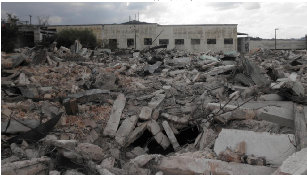
Figura 81: Edifício da tinturaria e depósito de algodão da Unidade I totalmente destruído. Destaca-se estruturas ainda edificadas do edifício da fiação e tecelagem ao fundo. Foto: Mariana Gonçalves Moreira. Junho de 2014.
