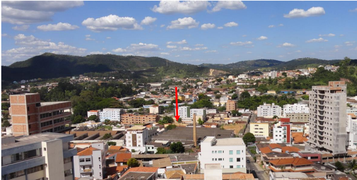
Figura 75: Seta indica a localização da Unidade I da Companhia Industrial Itaunense. Destacam-se prédios em construção na área envoltória. Foto: Mariana Gonçalves Moreira. Novembro de 2013.
