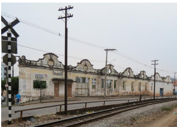
Figura 71: Fachada do edifício de atividades de suporte à tecelagem. Foto: Mariana Gonçalves Moreira. Outubro de 2012.
