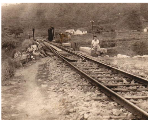
Figura 18: Vista do trecho da Estrada de Ferro sobre o Rio São João. Foto tirada na década de 50. Fonte: Acervo da Prefeitura Municipal de Itaúna.
