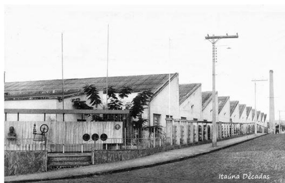
Figura 22: Vista de parte da Unidade I da Cia. Industrial Itaunense, com destaque para os shelds . Fonte: Itaúna em Décadas. Disponível em: https://www.facebook.com/itauna.decadas?fref=phot . Acesso em fevereiro de 2014.
