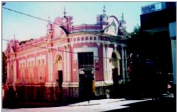
Figura 47: Antiga residência de João de Cerqueira Lima Rua Silva Jardim, 333, Centro. Inventariada em 2003. Fonte: Acervo do Arquivo Público Municipal de Itaúna.
