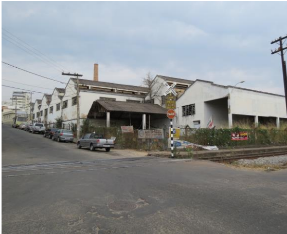
Figura 79: Fachada do edifício da tinturaria e depósito de algodão da Unidade I. Foto: Mariana Gonçalves Moreira. Outubro de 2012
