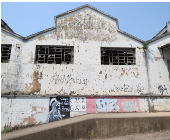
Figura 54: Fachada da Unidade I da Companhia Industrial Itaunense. Nota-se a pintura desgastada, os vidros das janelas quebrados e a ocorrência de grafites. Foto: Mariana Gonçalves Moreira. Janeiro de 2013.
