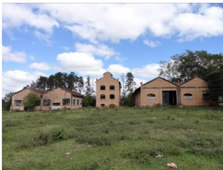
Figura 59: Ruínas da Fábrica dos Matarazzo, em Caçapava, São Paulo. Foto: Mariana Gonçalves Moreira, julho de 2013.
