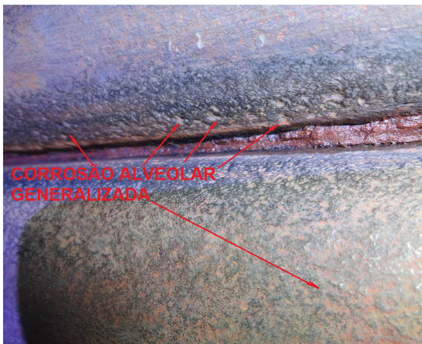
Figura 4. 17 – Foto da superfície interna do duto inspecionado, apresentando as áreas corroídas (Fonte: Imagens cedidas pela empresa SMS group).
