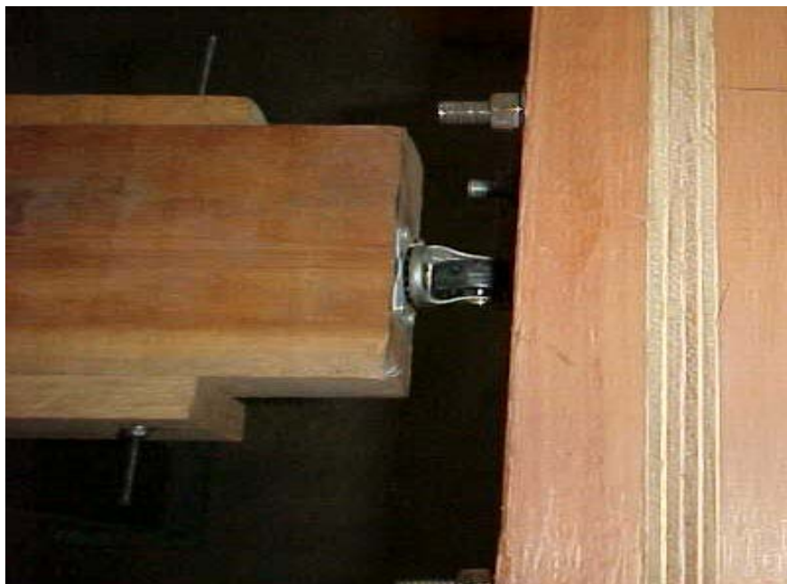
FIGURA 4.18 a –Vista Superior do Travamento lateral das Vigas
