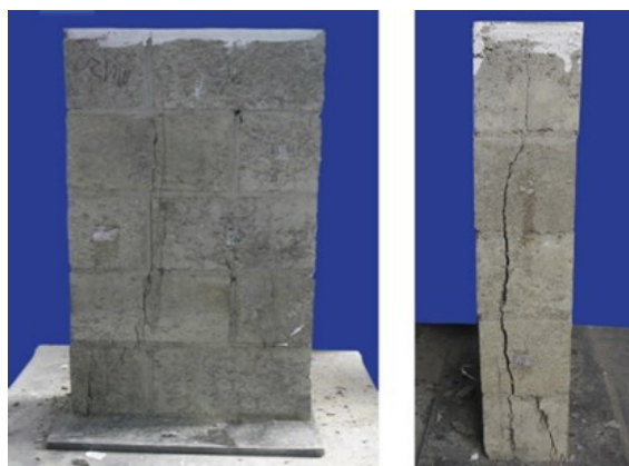
Figura 2.3 – Modo de falha típico de pequenas paredes de alvenaria: (a) fissuração na vista frontal; e (b) fissuração na vista lateral.
