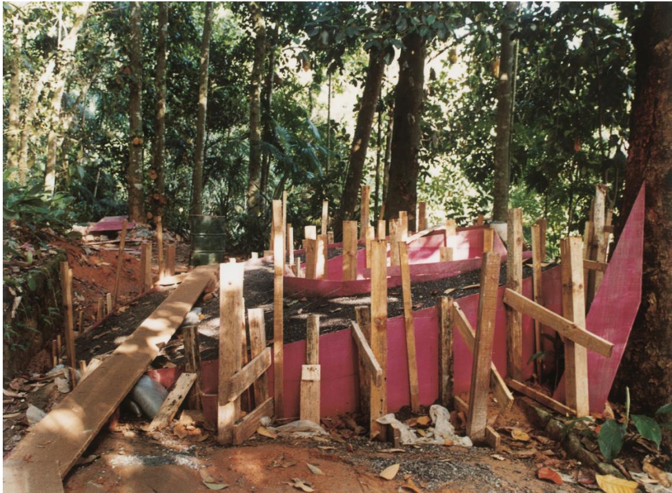
Figura 133. Construção de Calado I , de Nuno Ramos (2002)
