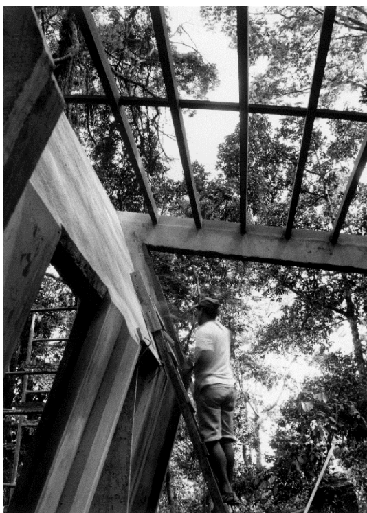
Figura 86. Execução da alvenaria na instalação New House , de Lygia Pape (2002)
