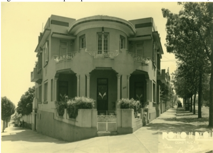
Figura 90 – Fachada principal de uma casa localizada à Rua da Bahia, esquina da Avenida Bias Fortes
