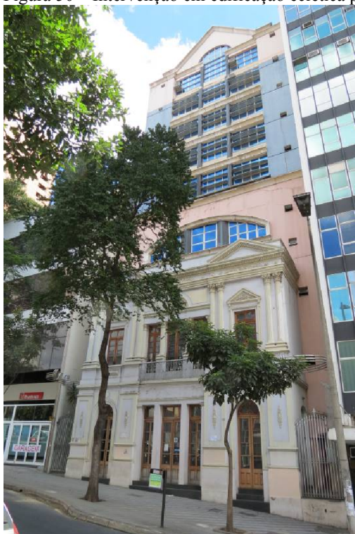
Figura 50 – Intervenção em edificação eclética preservando somente a fachada
