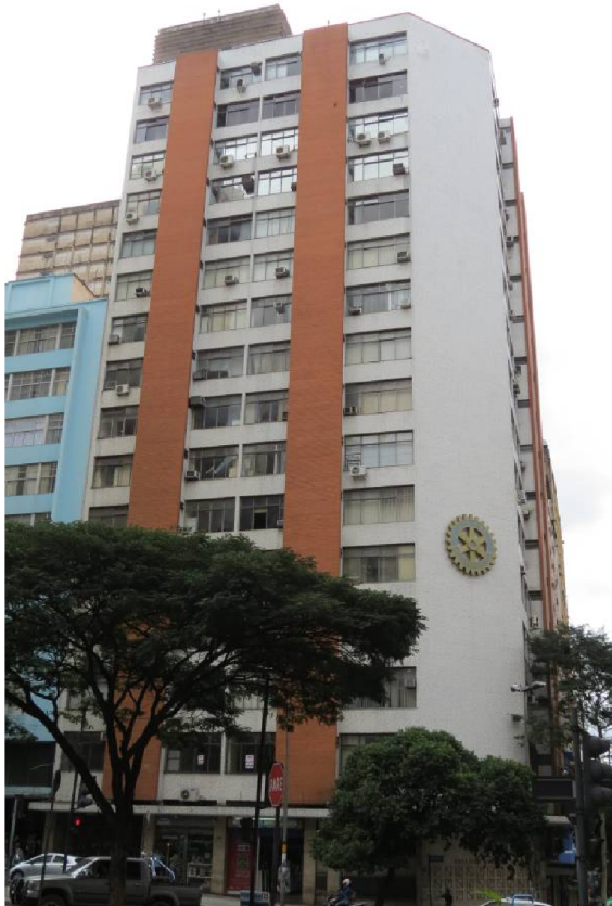
Figura 37 – Edifício Rotary, tipologia de uso comercial / serviços em estilo moderno
