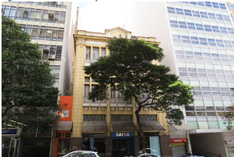
Figura 20 – Edifício Parc Royal
