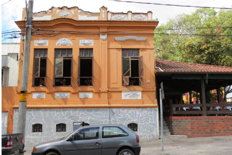
Figura 38 – edificação em estilo eclético de uso comercial / serviços com intervenção contemporânea
