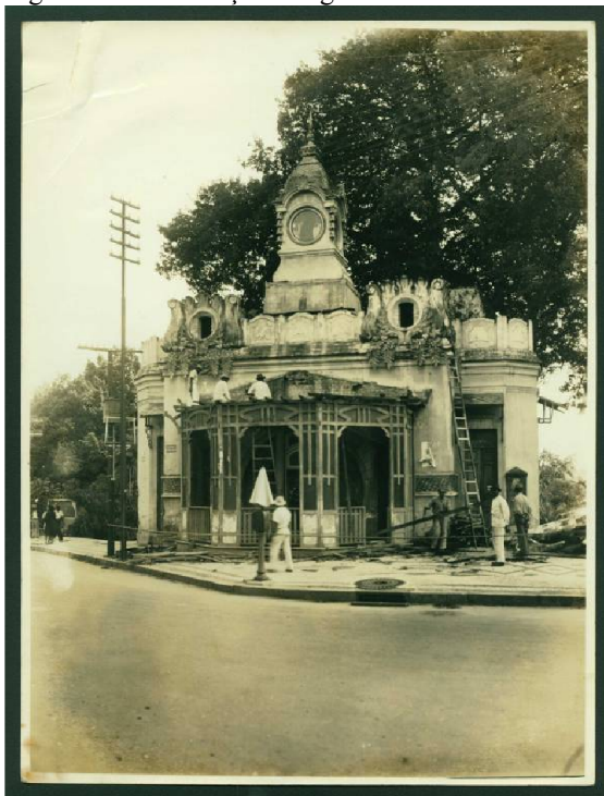
Figura 76 – Demolição da agência de bondes
