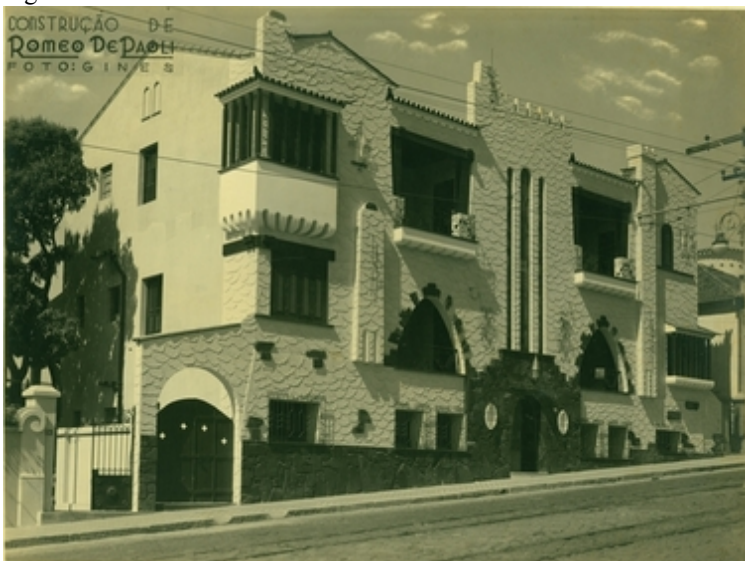
Figura 89 – Edifício Teixeira da Rocha
