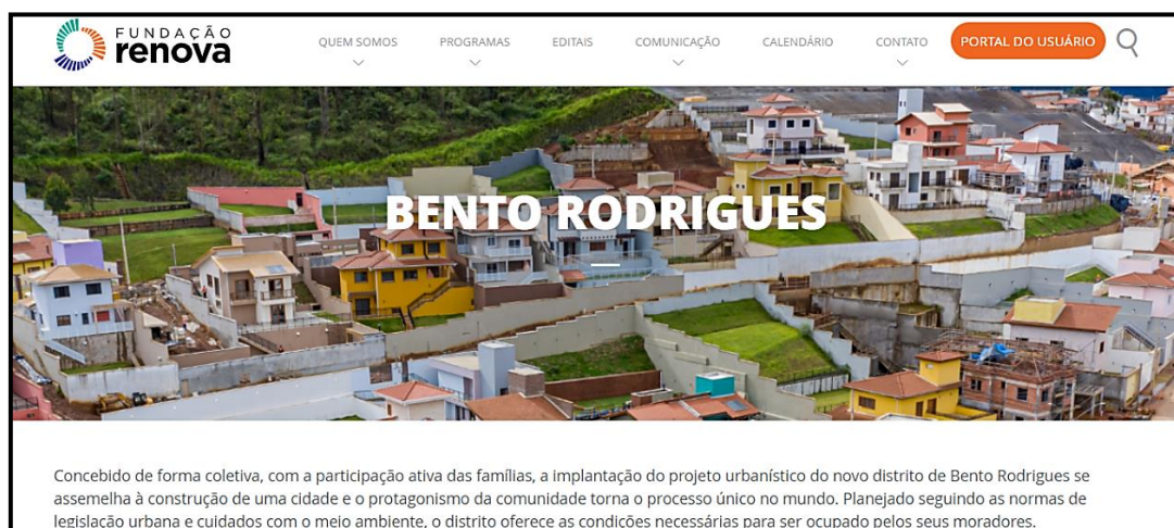
Figura 13- Vista parcial do “Novo Bento Rodrigues”
