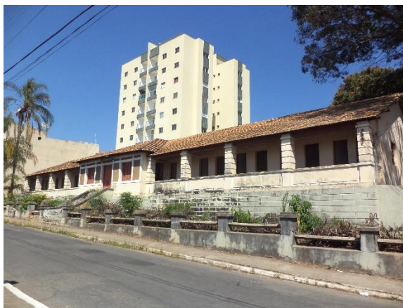
Figura 59 Edificação residencial multi familiar inserida na paisagem do Conjunto Habitacional
