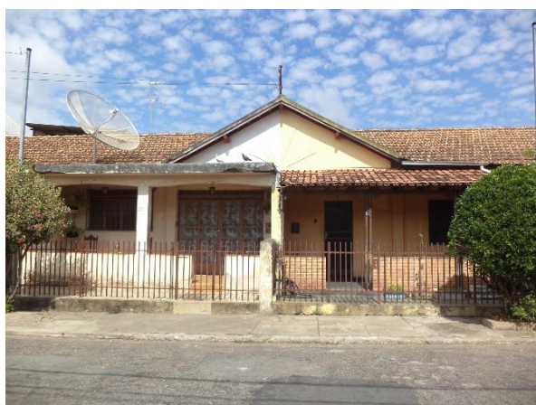
Figura 30 Imóvel residencial em fita na rua José Custódio Filho. Tipo RUF.
