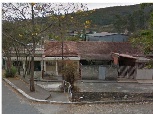
Figura 32 Imóvel residencial em fita situado na Rua Primeiro de Maio. Tipo RUF.
