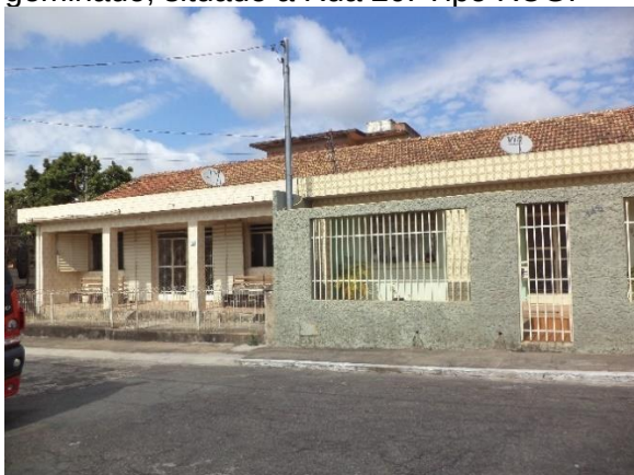
Figura 26 Imóvel residencial unifamiliar geminado, situado à Rua 20. Tipo RUG.
