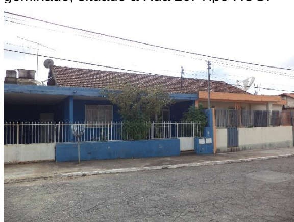
Figura 27 imóvel residencial unifamiliar geminado, situado à Rua 20. Tipo RUG.
