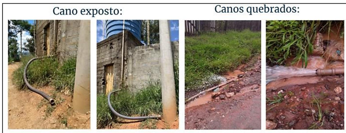
Figura 63: Problemas na infraestrutura no bairro Parque da Cachoeira (2021) apresentados pela ACOPAPA na reunião com MMPMG, AECOM e Vale
