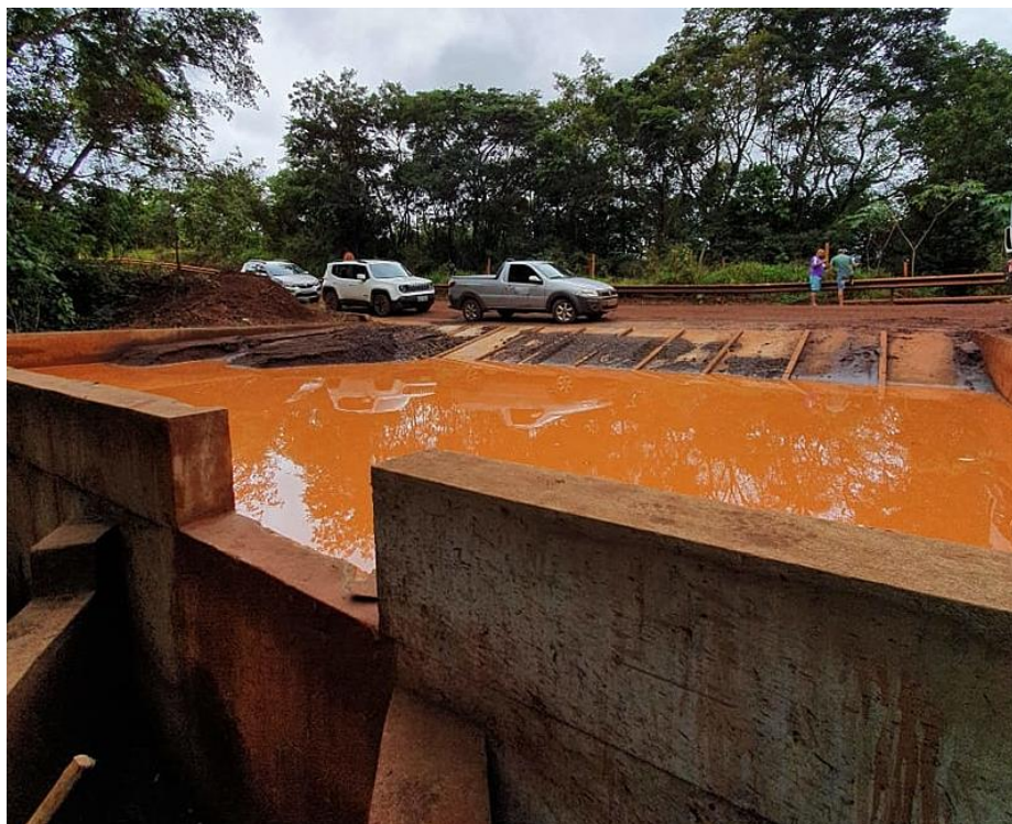
Figura 46: Caixa de sedimentos que provocou a contaminação das águas do Tejuco
