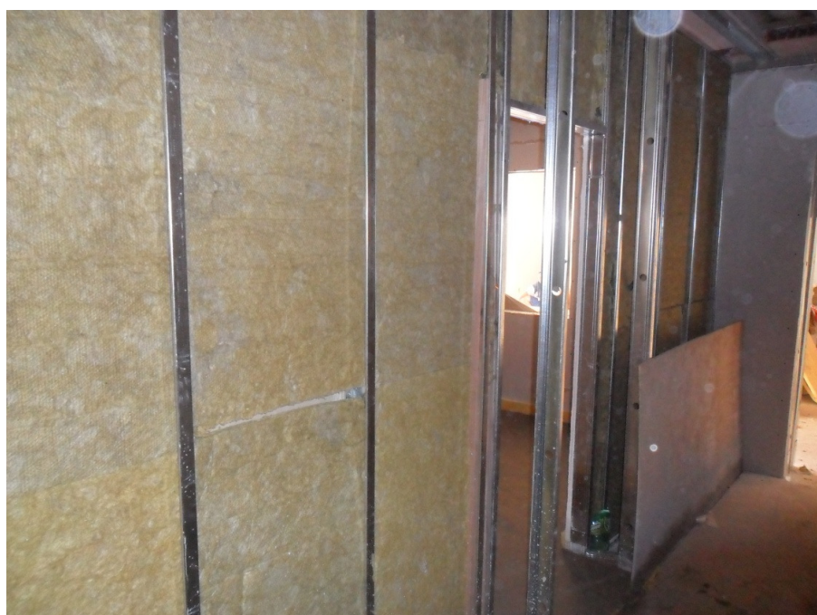
Figura 12: Divisórias em Drywall (SENGEL CONSTRUÇÕES LTDA, 2011)
