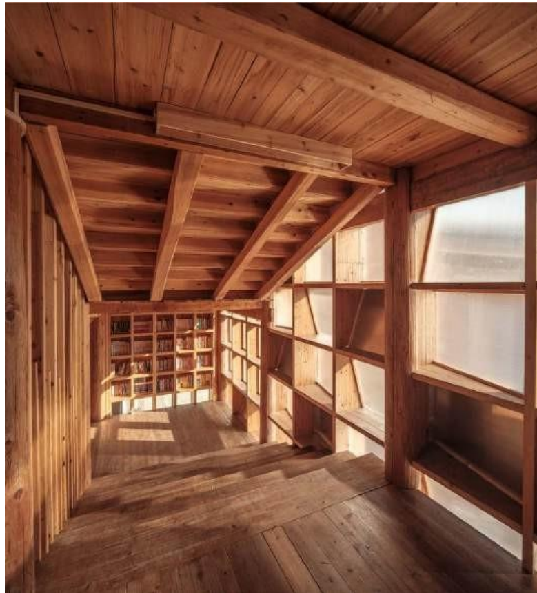
Imagem 30: Interior da Pingtan Book House com a maioria dos elementos concebidos em madeira de abeto chinês, material de construção tradicional da localidade.
