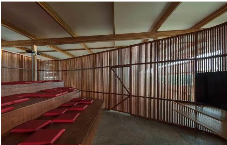
Imagem 7: Sala de TV. Para uma melhor circulação de ar, os ambientes coletivos da edificação são delimitados apenas por ripados esbeltos de madeira.
