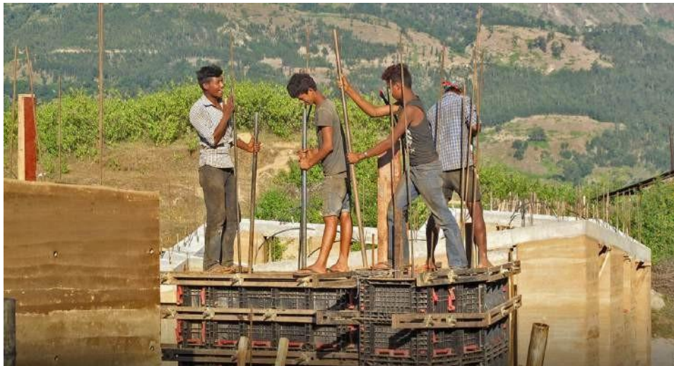
Imagem 21: Moradores erguendo paredes de taipa de pilão do hospital.
