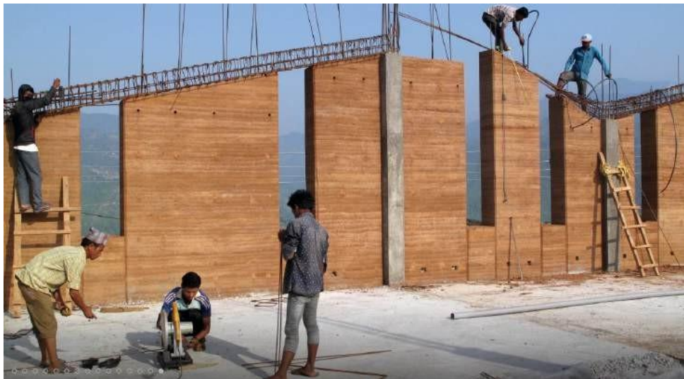
Imagem 22: O hospital em obras, com as paredes de taipa de pilão já adiantadas.
