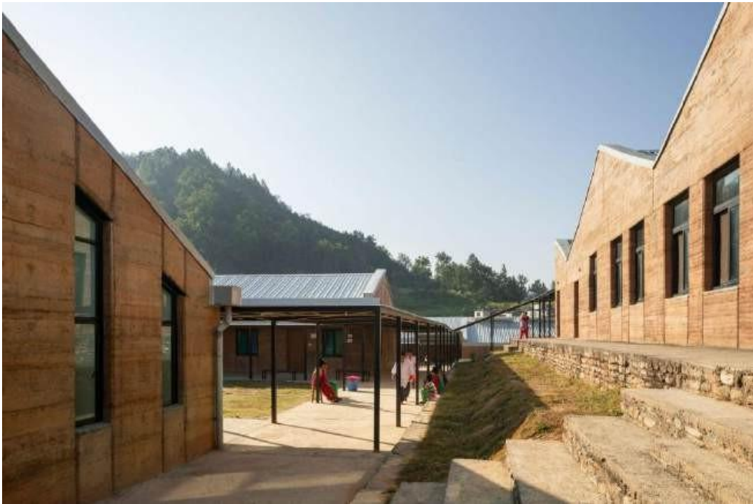
Imagem 24: Área externa do Hospital Bayalpata, com arrimos e fundações visíveis. Nota-se a eficiente adaptabilidade do complexo hospitalar ao terreno irregular.
