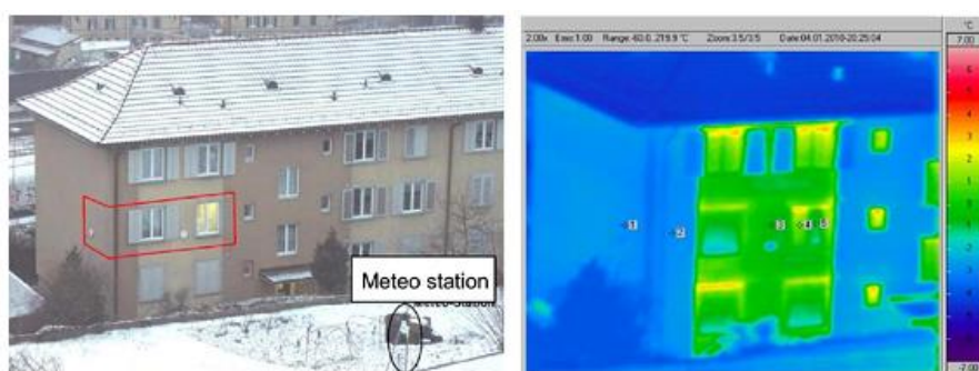
Figura 3.16: Vista da fachada de um edifício e do termograma correspondente. Fonte: Lehmann et al. (2013), p. 535
