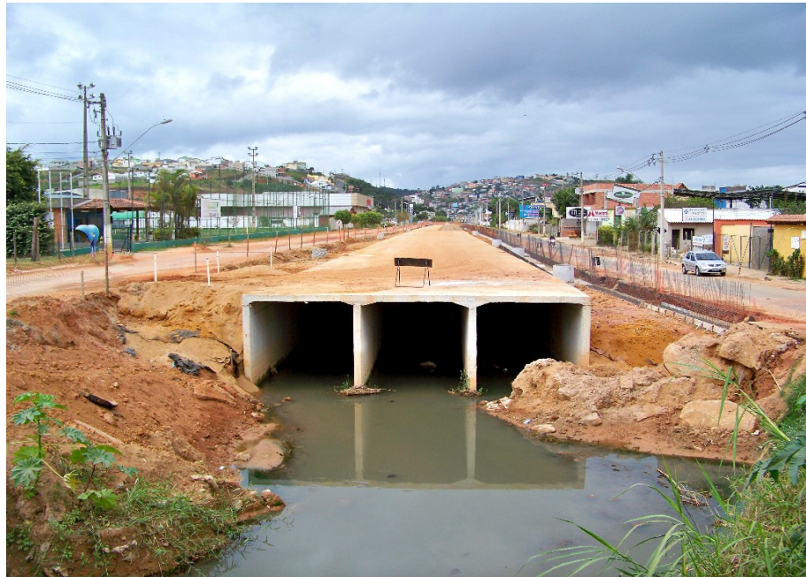
Figura 6 - Trecho canalizado do córrego São Pedro e despejo de esgoto bruto Fonte: Jorge A. Ferreira (2011)
