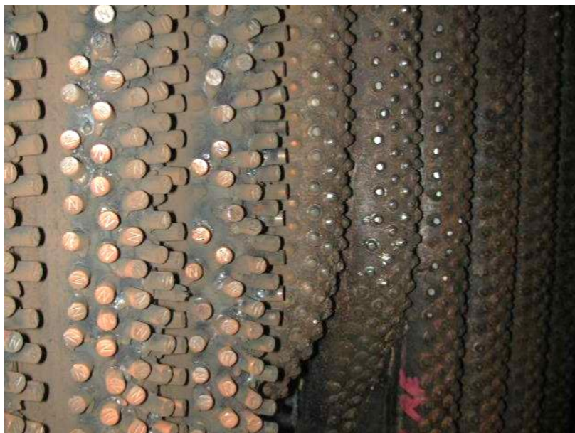
Figura 3-12 - Tubos de área repinada conforme procedimentos corretos (PAOLIELLO et al. , 2005).
