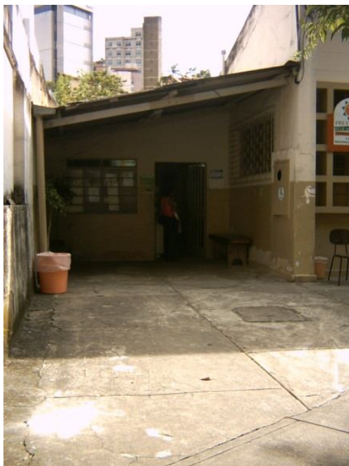
Foto 15 – Chegada da UBS (recepção), evidente ampliação.
