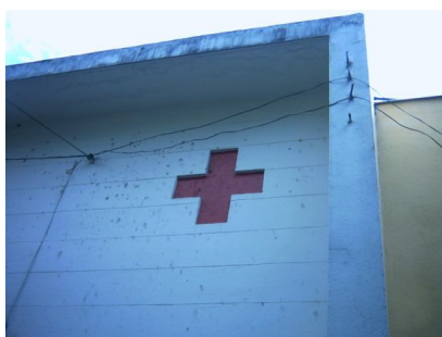
Foto 13 – Detalhe fachada da UBS.
