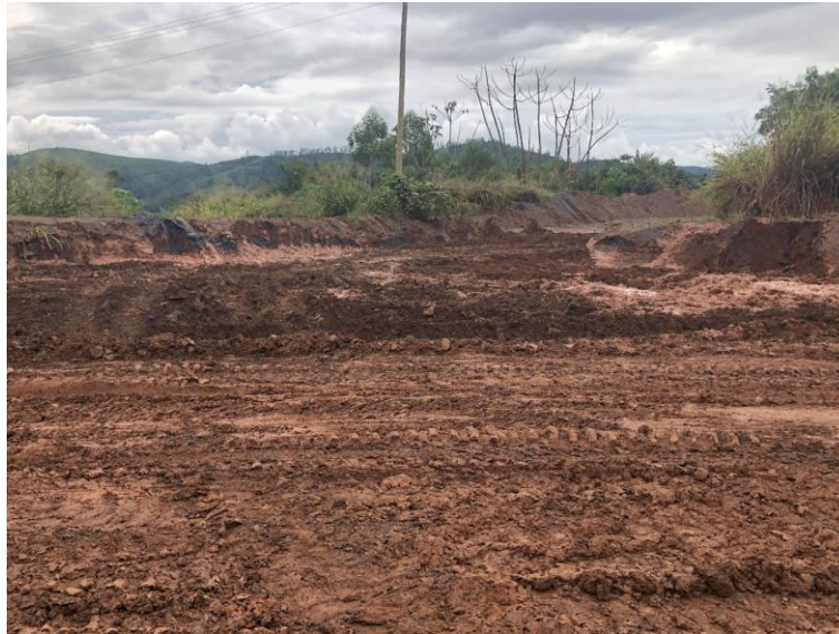
Figura 5.32 - Ocorrência da segregação de agregados de alta intensidade, sobretudo, nos canteiros e proporções centrais (menos transitadas) das estradas não revestidas.
