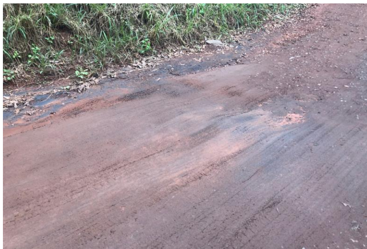
Figura 5.20 - Formação de corrugações de baixa intensidade, caracterizadas, sobretudo, pela baixa frequência e pequena profundidade.
