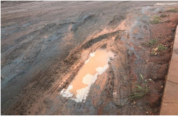
Figura 5.27 - Estrada não revestida com mais de 30% de sua superfície coberta por buracos.
