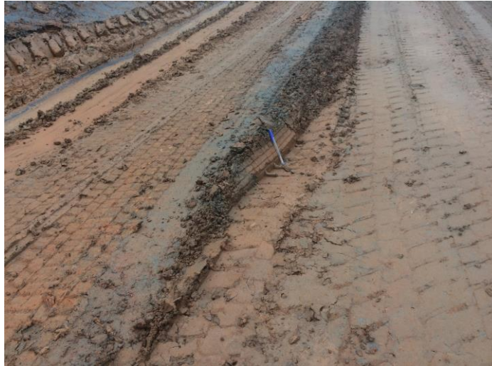
Figura 5.12 - Solo caracterizado por formação argilosa, dificultando a infiltração pluviométrica, propiciando a formação de trilhas.
