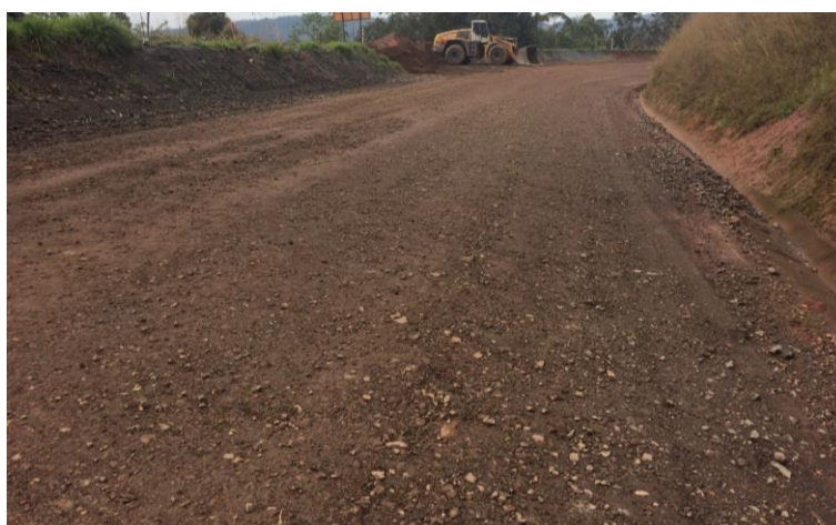
Figura 5.5 - Ausência do defeito qualitativo corrugações na pista experimental construída.
