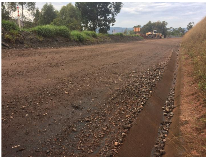
Figura 5.14 - Visão geral da pista construída, sem maiores defeitos qualitativos que justifiquem a formação da segregação de agregados.
