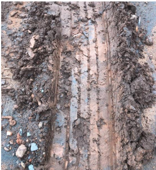
Figura 5.29 - Evidência de trilha de roda de alta severidade, caracterizada por sua profundidade.
