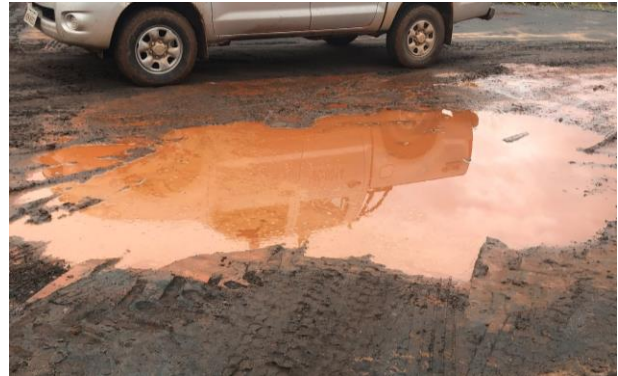
Figura 5.27 - Estrada não revestida com mais de 30% de sua superfície coberta por buracos.
