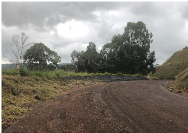
Figura 5.22 - Não foi detectada a presença de buracos no revestimentos construído na pista experimental.
