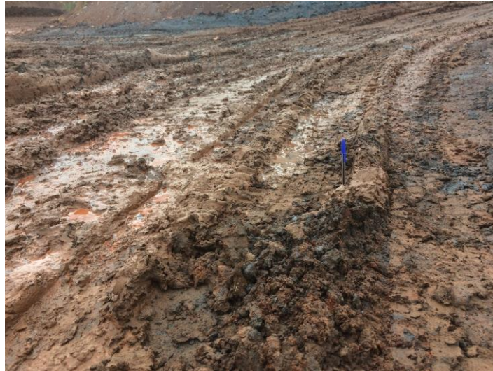
Figura 5.10 - Predominância do defeito qualitativo trilhas de rodas em um fragmento de estrada não revestida.
