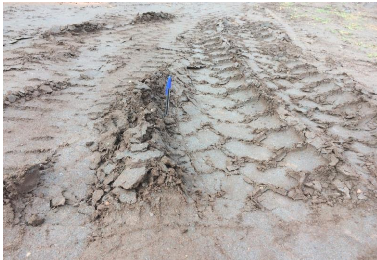
Figura 5.11 - O defeito qualitativo trilhas de rodas foi classificado como alto devido à sua alta frequência e à altura das trilhas formadas no solo.
