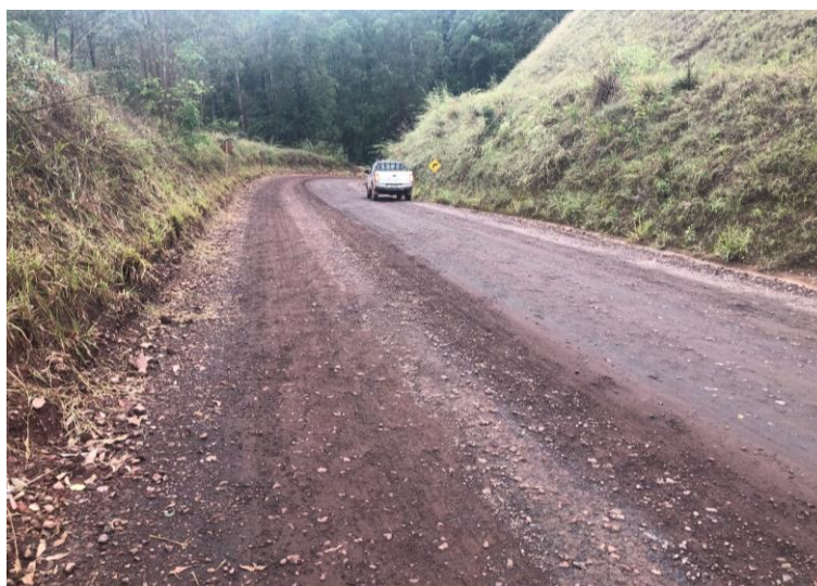
Figura 5.18 - Estrada experimental após 11 meses de utilização.
