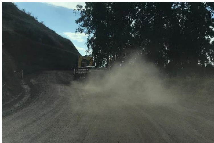
Figura 5.36 – Defeito qualitativo poeira, classificado como alta intensidade advinda do tráfego de veículos sobre estrada não revestida.
