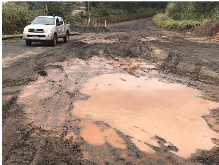
Figura 5.27 - Estrada não revestida com mais de 30% de sua superfície coberta por buracos.
