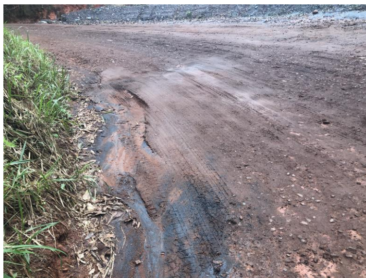
Figura 5.38 - Trecho com revestimento primário construído exclusivamente com escória, 4 meses após a sua construção.
