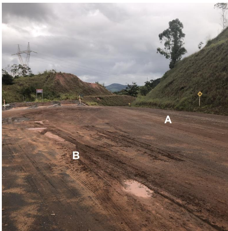
Figura 5.37 - Paralelamente, em A, revestimento primário construído a partir da mistura estéril e escória e, em B, trecho em solo natural.
