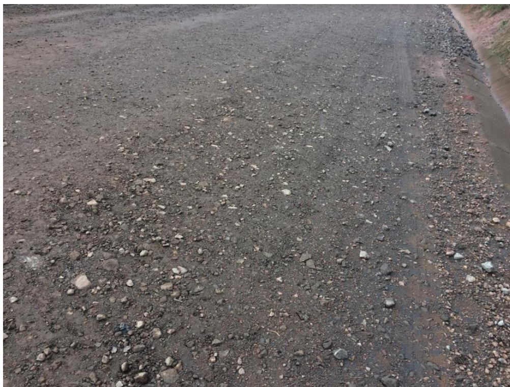
Figura 4.5 - Mistura finalizada, aplicada e compactada em 50% de seu volume inicial.
