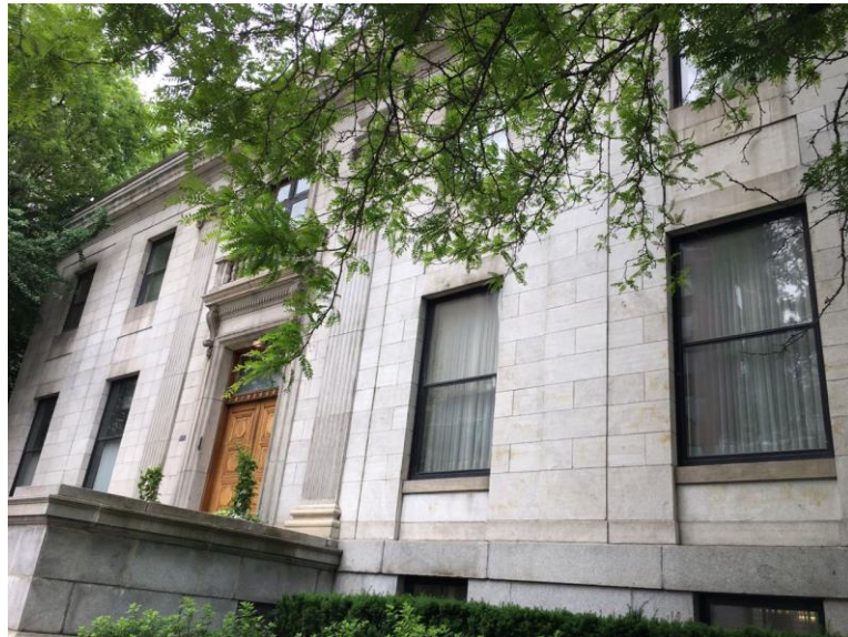
Figura 8: Edifício Mount Royal Club
