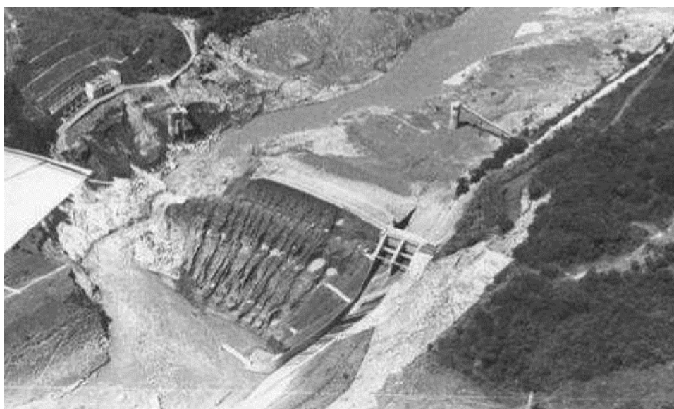
Figura 4.2: Ruptura por galgamento da UHE Euclides da Cunha.
