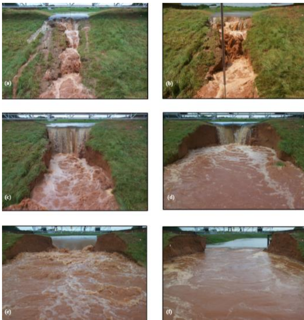
Figura 4.8: Processos de erosão durante o teste de abertura (solo 1, aterro 1): (a) riachos e cascatas de pequenas quedas durante o estágio I em t = 7 min, (b) consolidação de pequenas quedas durante o estágio I em t = 13 min, (c) corte na crista a jusante, transição do estágio I para o estágio II em t = t_1 \approx 16 min, (d) corte na crista a montante, transição do estágio II para o estágio III em t = t_2 \approx 16 min, (e) fluxo através de brecha durante estágio III em t = 40 min, e (f) transição do estágio III para o estágio IV em t = t_3 \approx 51 min.
