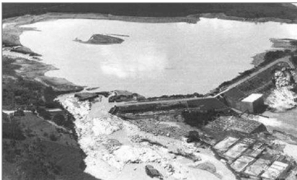
Figura 4.3: Ruptura da UHE Armando Sales de Oliveira após o galgamento, em 20/01/1977. Fonte: Saliba (2009).
