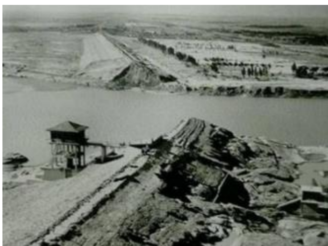
Figura 4.1: Ruptura da barragem de Banqiao.
