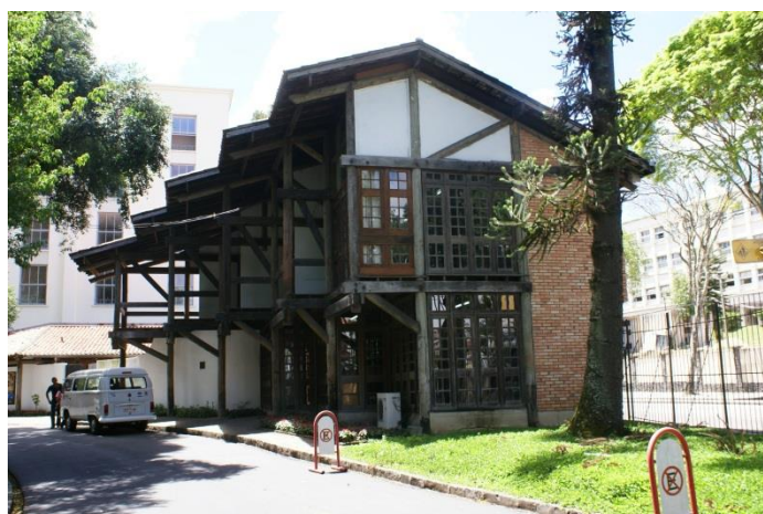
Figura 77: Edifício Administrativo Foto de Izabella Galera
