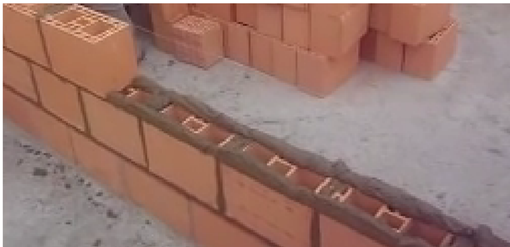
Figura 23 – Assentamento de bloco cerâmico com argamassa.
