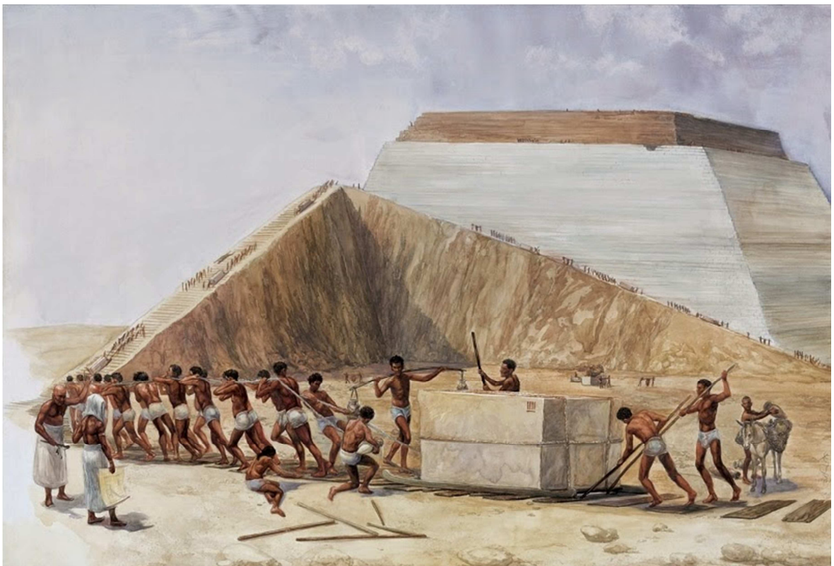
Figura 1 – Trabalhadores na construção das pirâmides.
