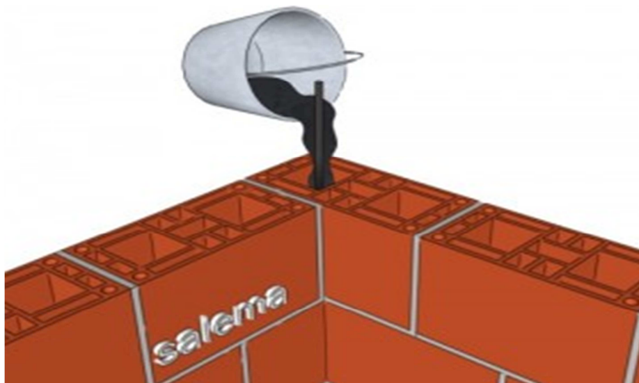
Figura 24 – Graute sendo utilizado em local previsto.
