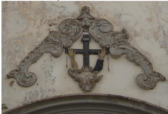
FIGURA 3 – Conjunto escultórico da sobreverga
