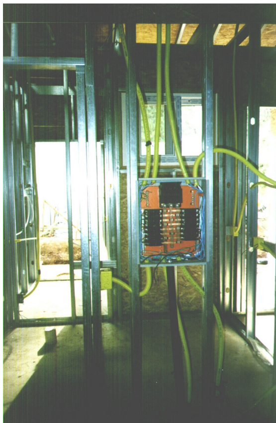
FIGURA 3.16 – Instalações elétricas do sistema gesso acartonado
