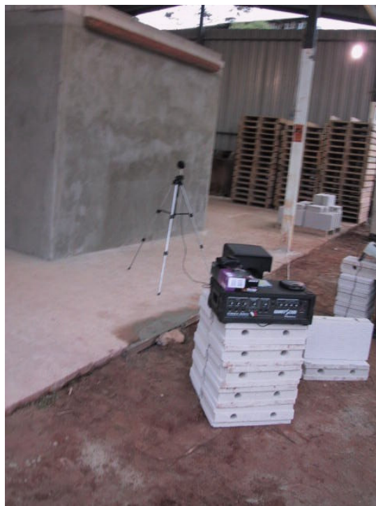
FOTO 5.1 – Câmara de ensaio I usada na medição do isolamento sonoro do bloco de concreto celular autoclavado
