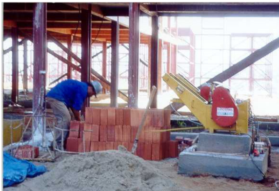
FIGURA 3.4 – Alvenaria de blocos cerâmicos e estrutura metálica
