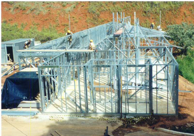
FIGURA 3.1- Sistema construtivo Steel Framing
