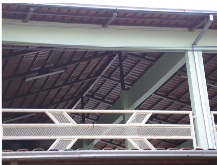
FOTO 1.1- Cobertura com engradamento metálico
