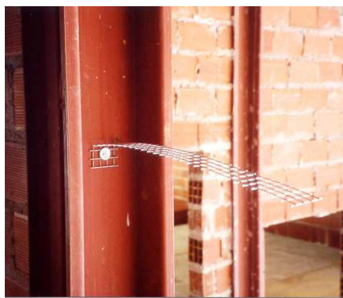
FIGURA 3.5 – Uso de tela metálica para garantir a estabilidade da alvenaria
