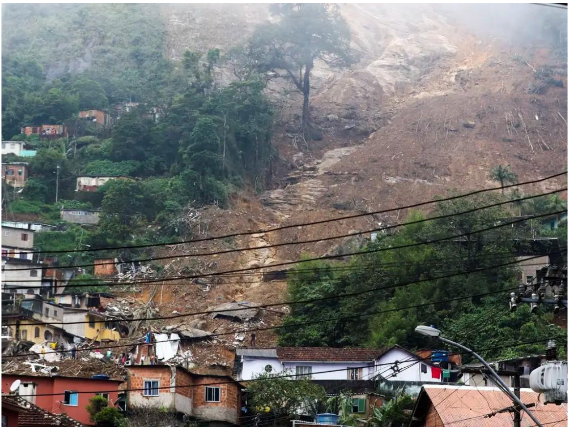
Figura 3 - Deslizamento de terra no Morro da Oficina, após a chuva que atingiu Petrópolis, 16 de fevereiro de 2022. Fonte: Tânia Rêgo/Agência Brasil, Petrópolis-RJ.
