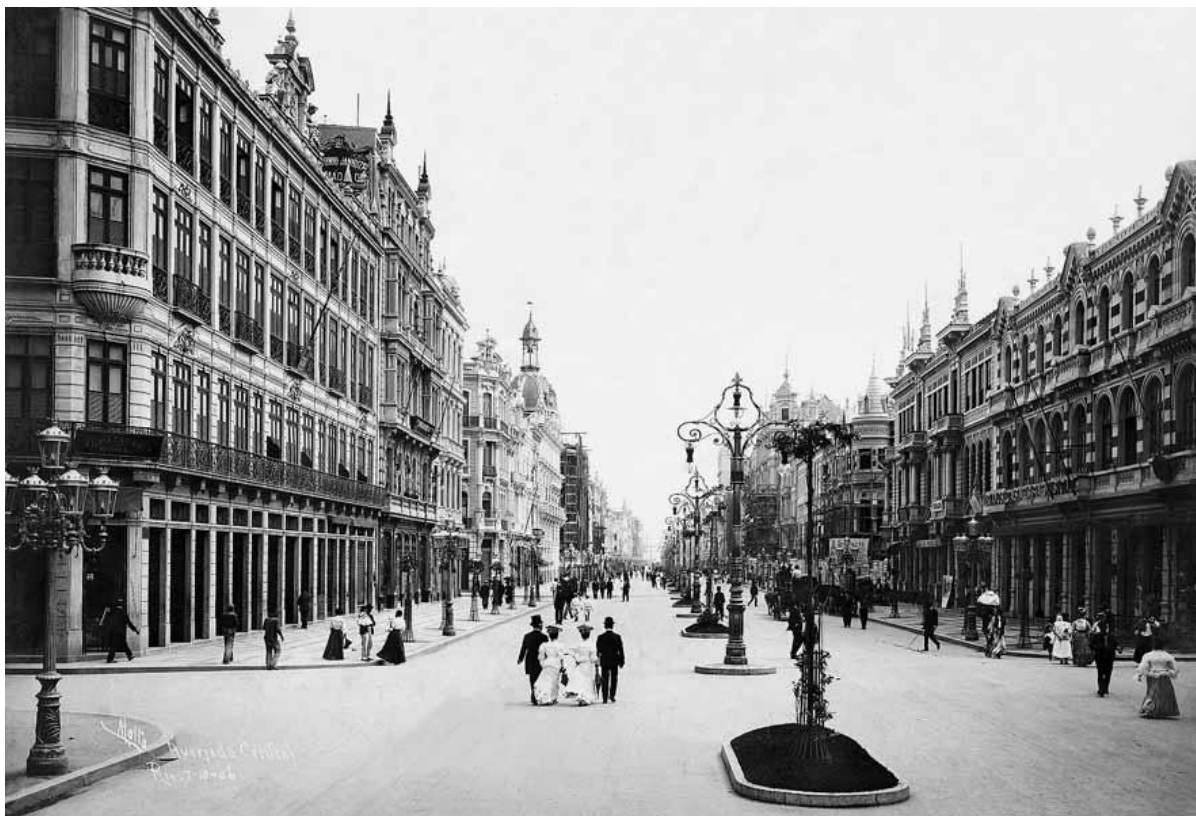
FIGURA 11 - Av. Central (Rio de Janeiro) depois da reforma
