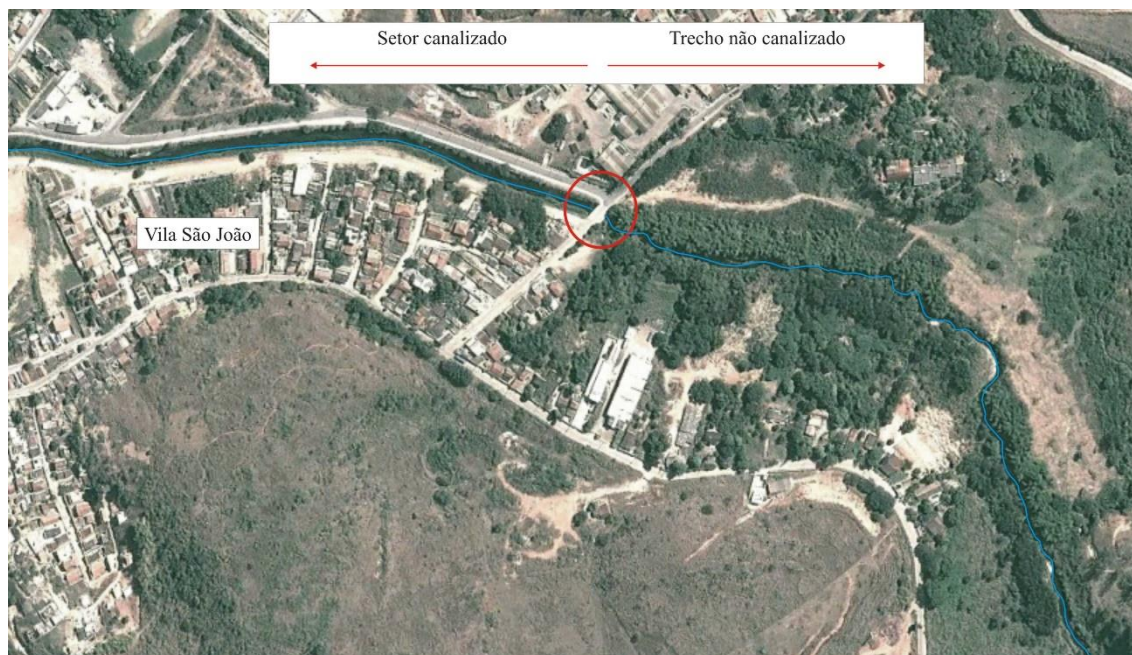
Figura 5.12 – Final da canalização do Rio Todos os Santos (demarcada com o círculo vermelho). Note a que a jusante do trecho canalizado o rio se torna meandrante, uma vez que este setor não sofreu intervenção. Imagem Google Earth Pro.
