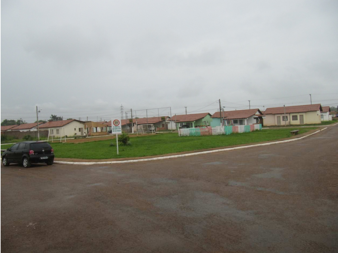
Figura 4: Vista parcial do condomínio Vila Verde
