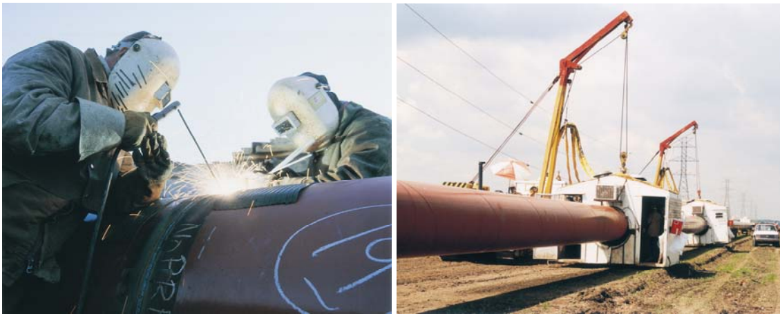
FIGURA 4.2: Soldagem manual de dutos [43].
