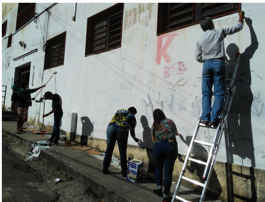
Figura 6: Preparando o muro. Fotografia: Rosilene Maria Vieira 2019.
