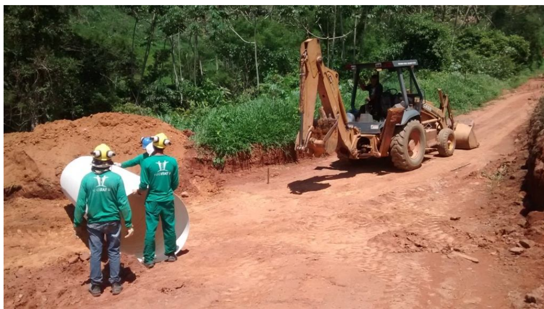
FIGURA 40 – Transporte tubos Rib Loc até a vala Fonte: Arquivo próprio, 2015
