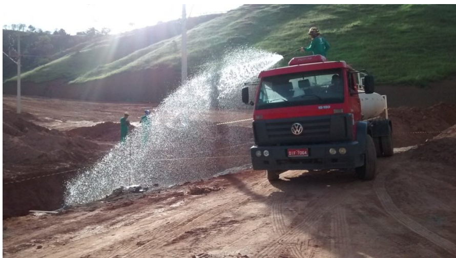
FIGURA 51 – Compactação com auxílio caminhão pipa Fonte: Arquivo próprio, 2015
