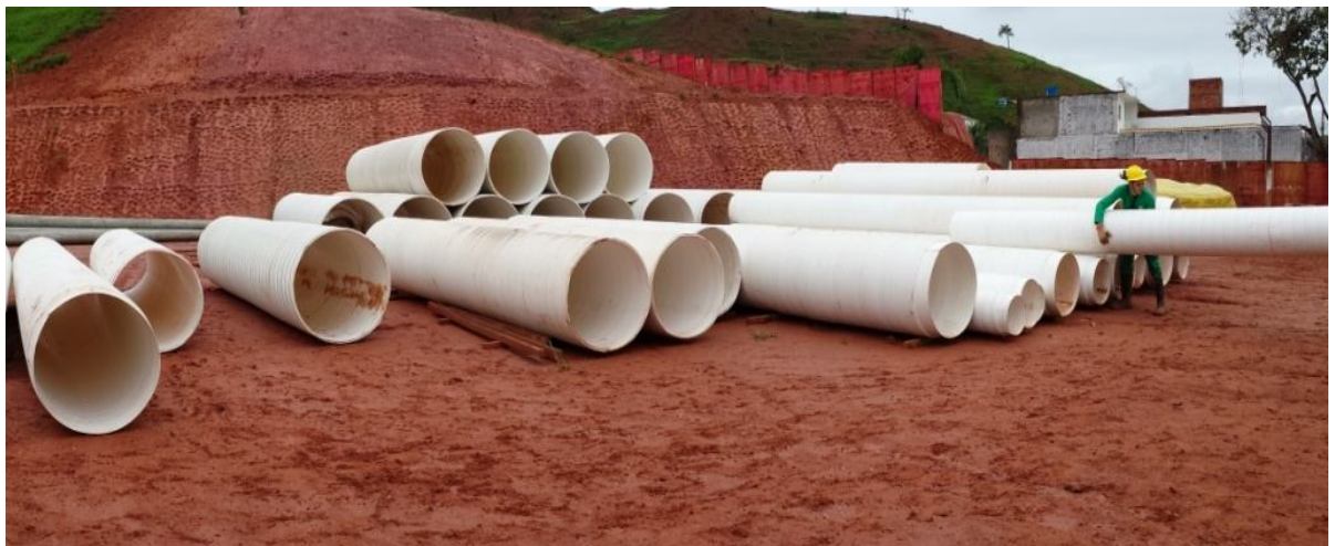
FIGURA 38 – Armazenamento tubos Rib Loc Fonte: Arquivo próprio, 2015
