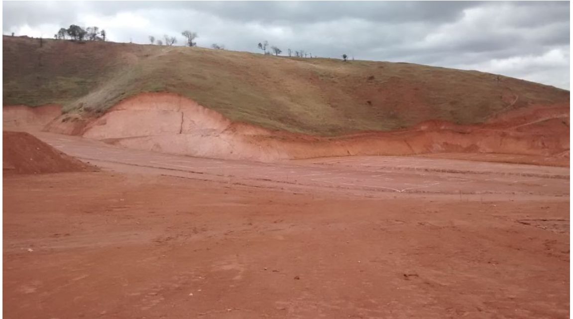
FIGURA 23 – Vista ruas “B”, “C” e “D” do condomínio Fonte: Arquivo próprio, 2014
