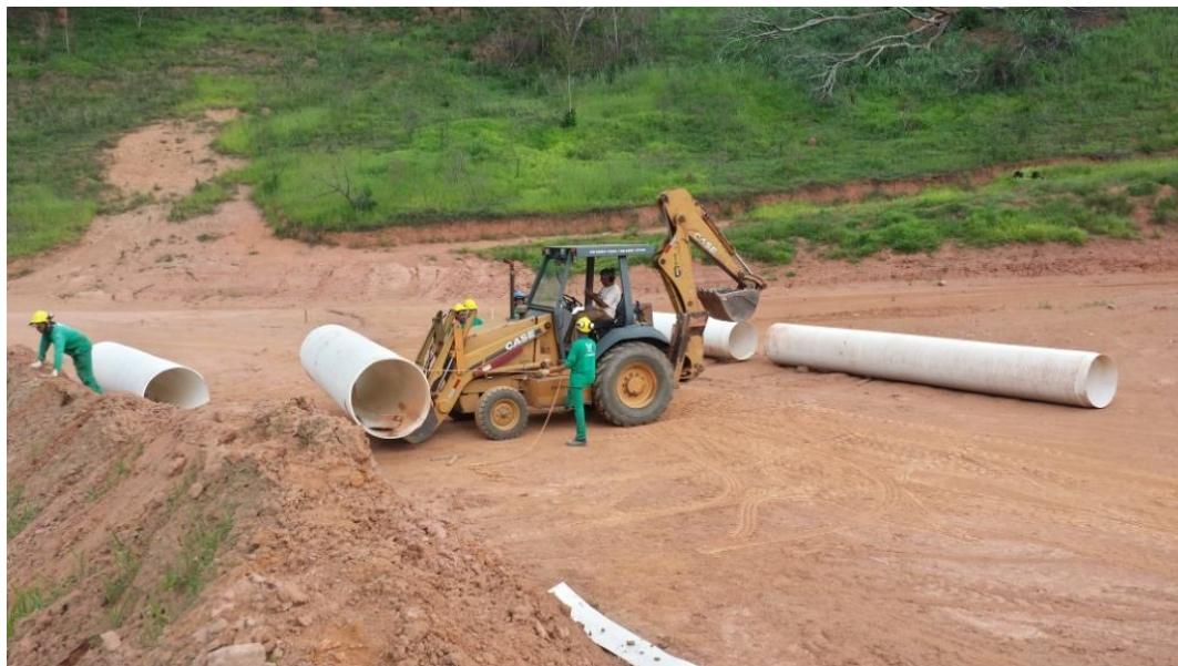
FIGURA 39 – Transporte tubos Rib Loc até a vala Fonte: Arquivo próprio, 2015
