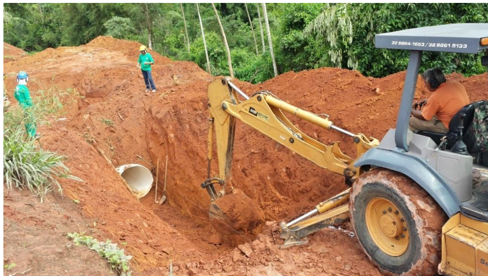
FIGURA 42 – Escavação valas Fonte: Arquivo próprio, 2015
