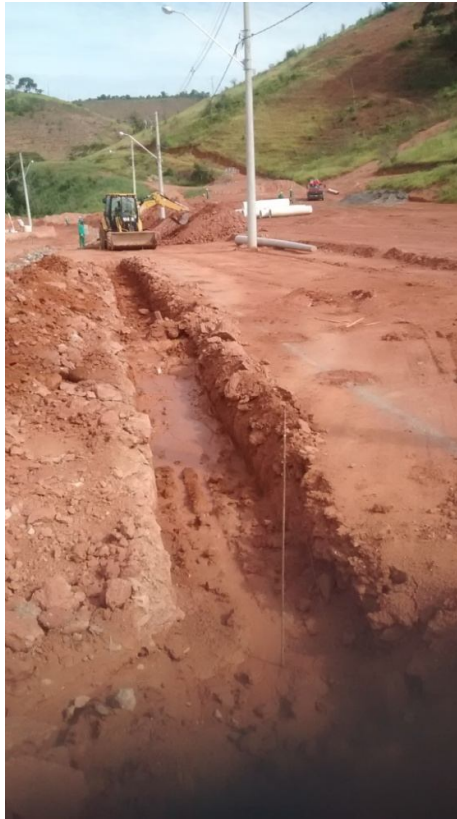
FIGURA 55 – Rede compactada Fonte: Arquivo próprio, 2015
