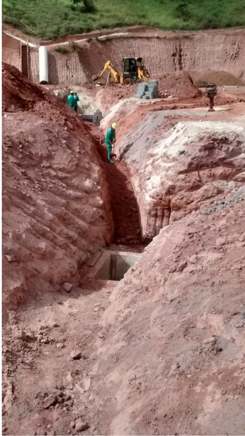
FIGURA 50 – Reaterro com material de escavação Fonte: Arquivo próprio, 2015
