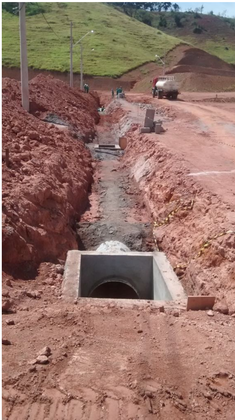
FIGURA 54 – Rede compactada Fonte: Arquivo próprio, 2015
