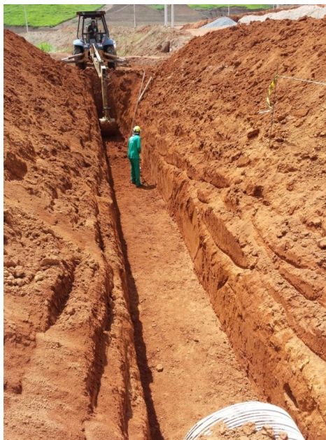
FIGURA 43 – Escavação valas e acerto manual fundo vala Fonte: Arquivo próprio, 2015
