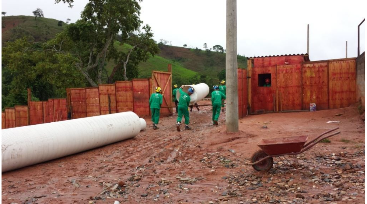
FIGURA 37 – Descarga Tubos Rib Fonte: Arquivo próprio, 2015
