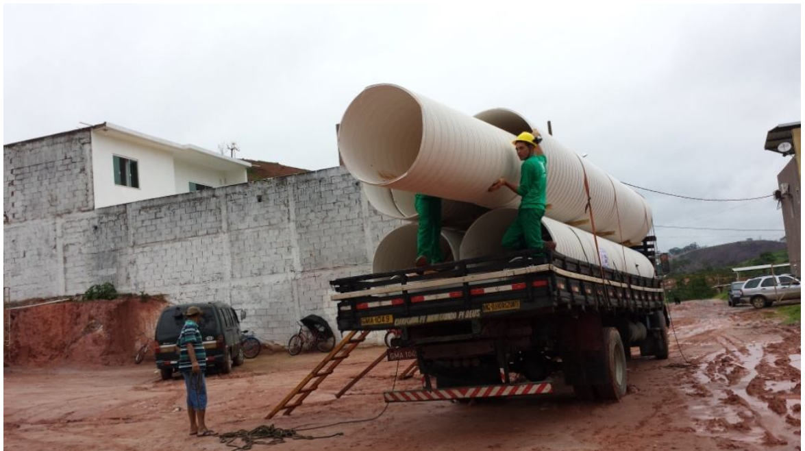
FIGURA 36 – Descarga tubos Rib Loc Fonte: Arquivo próprio, 2015
