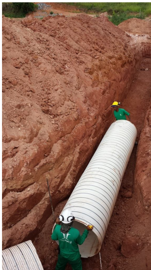
FIGURA 46 – Posicionamento manual tubos Rib Loc para colagem juntas Fonte: Arquivo próprio, 2015
