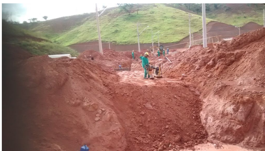
FIGURA 52 – Compactação com equipamento mecânico tipo Mikasa Fonte: Arquivo próprio, 2015
