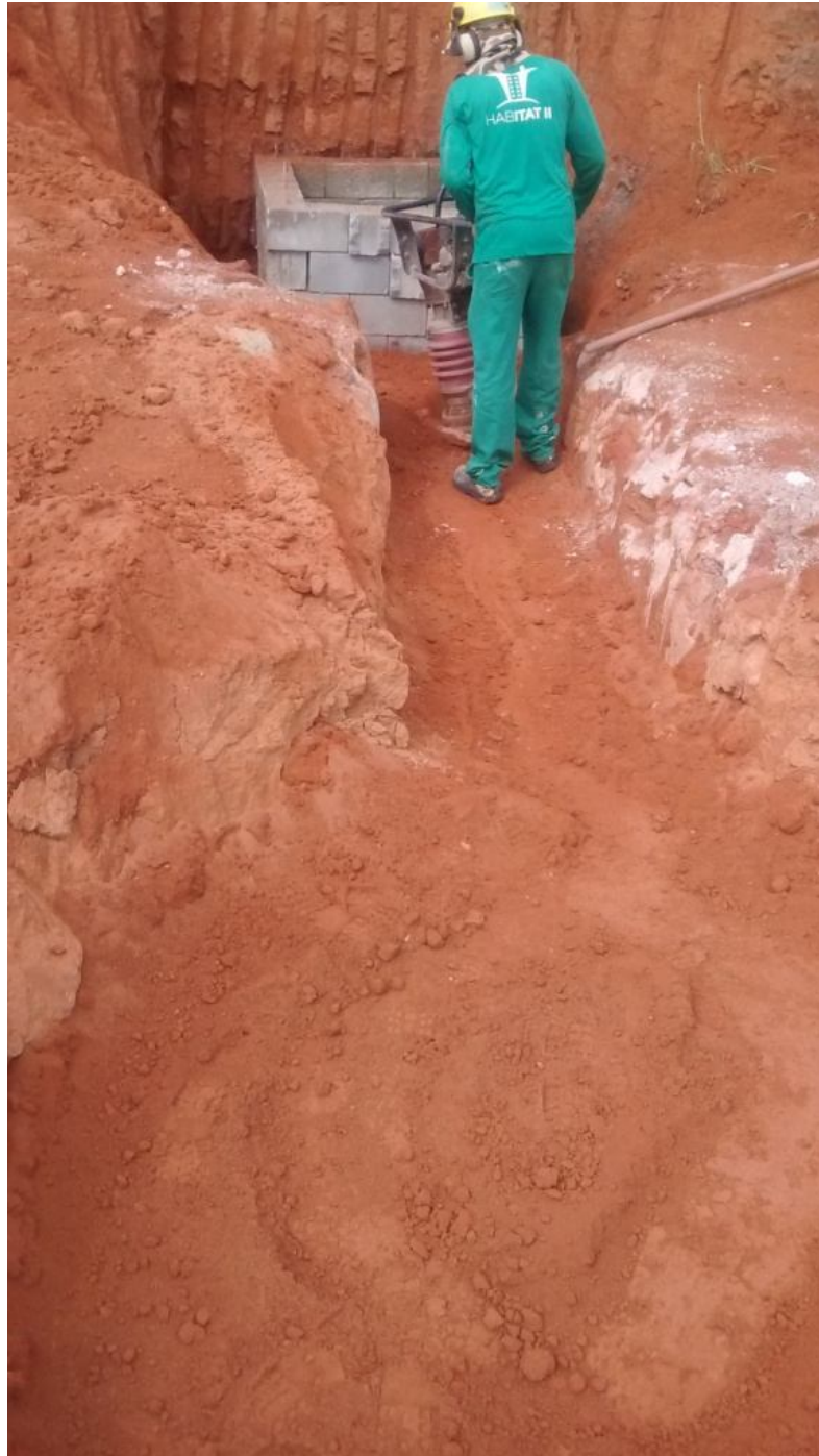
FIGURA 53 – Compactação com equipamento mecânico tipo Mikasa Fonte: Arquivo próprio, 2015
