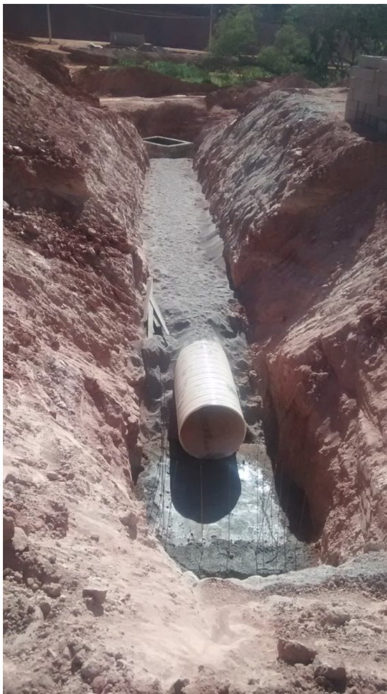
FIGURA 49 – Tubo reaterrado com pó de pedra Fonte: Arquivo próprio, 2015
