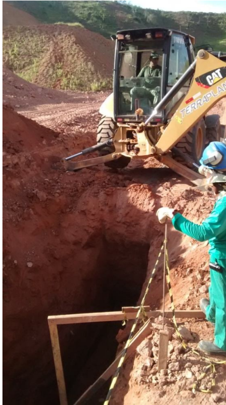
FIGURA 41 – Escavação valas Fonte: Arquivo próprio, 2015
