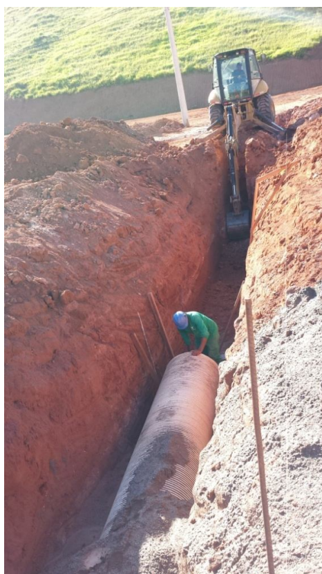
FIGURA 44 – Escavação valas e acerto manual fundo vala Fonte: Arquivo próprio, 2015
