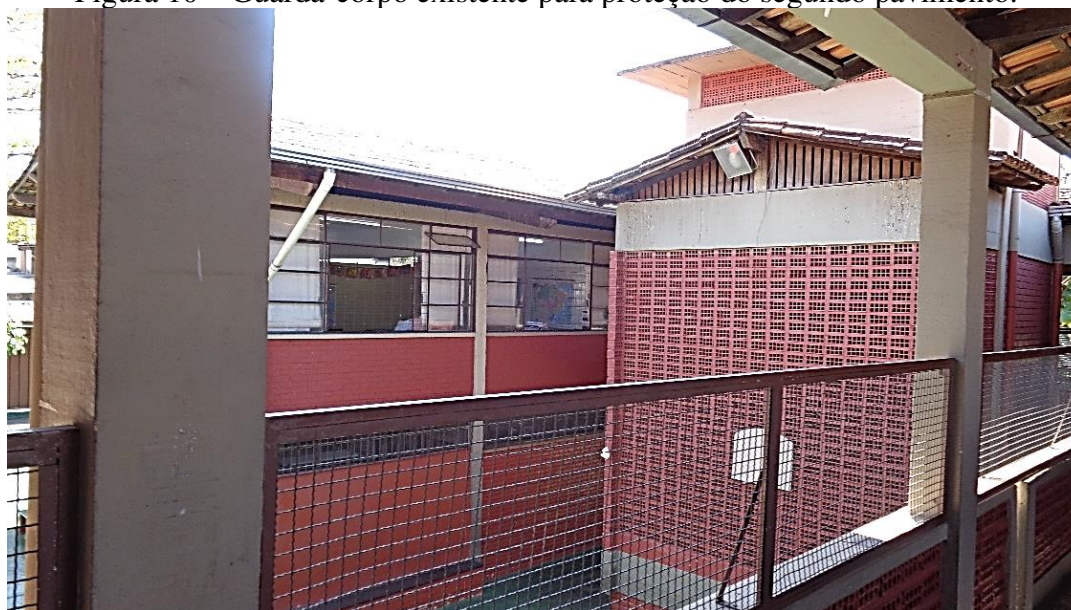
Figura 10 – Guarda-corpo existente para proteção do segundo pavimento.
