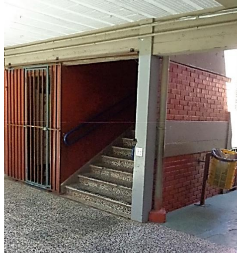
Figura 7 – Saída de Emergência do 2º pavimento, blocos 1, 2 e 3.
