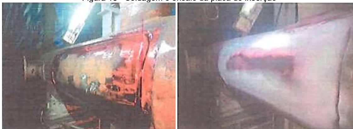
Figura 15 - Soldagem e ensaio da placa de inserção
