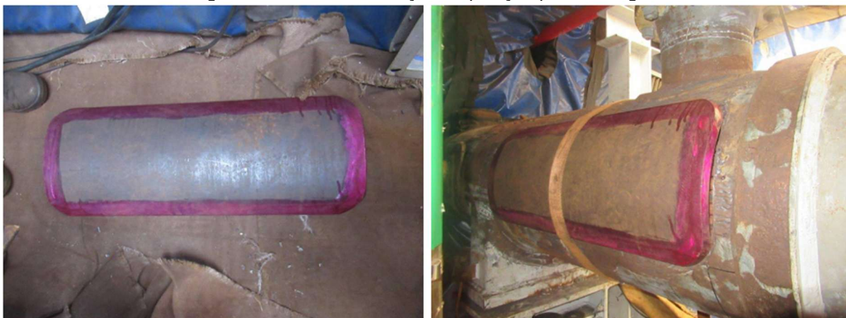
Figura 14 - Placa de inserção na posição para soldagem
