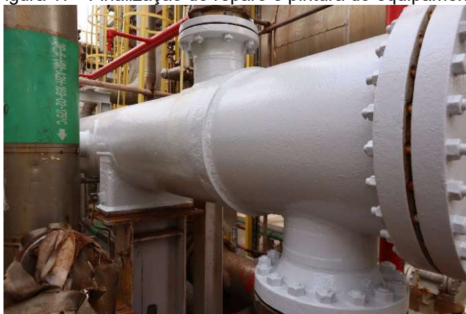
Figura 17 - Finalização do reparo e pintura do equipamento
