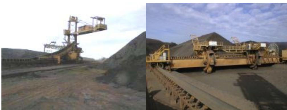
Figura 3.8.2 – Fotografias do sistema de empilhamento e retomada da mina de Fábrica, após a britagem primária.
