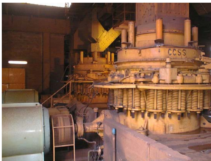
Figura 3.8.3 – Fotografia dos britadores cônicos secundários
