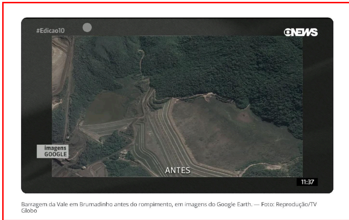
Figura 2: barragem da Vale em Brumadinho antes do rompimento, em imagens do Google Earth. Imagem retirada de: G1, 2019a.
